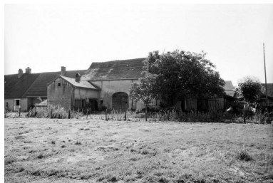
Vue générale. Phot. Yves Sancey IVR43_19753900487Z
