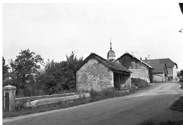
Fontaine-lavoir située rue de l'Eglise. Phot. Yves Sancey IVR43_19802500885X
