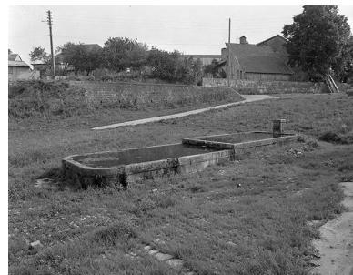
La fontaine inférieure située rue de la Perrière. Phot. Yves Sancey IVR43_19802500877X
