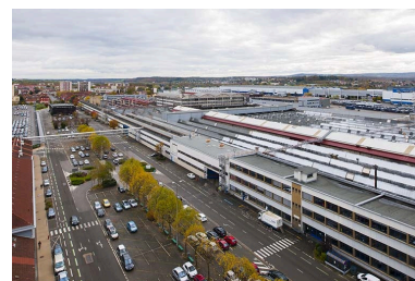
Vue perspective des ateliers de l'usine Peugeot de Sochaux-Montbéliard. Phot. Jérôme Mongreville IVR43_20132502774NUC4A
