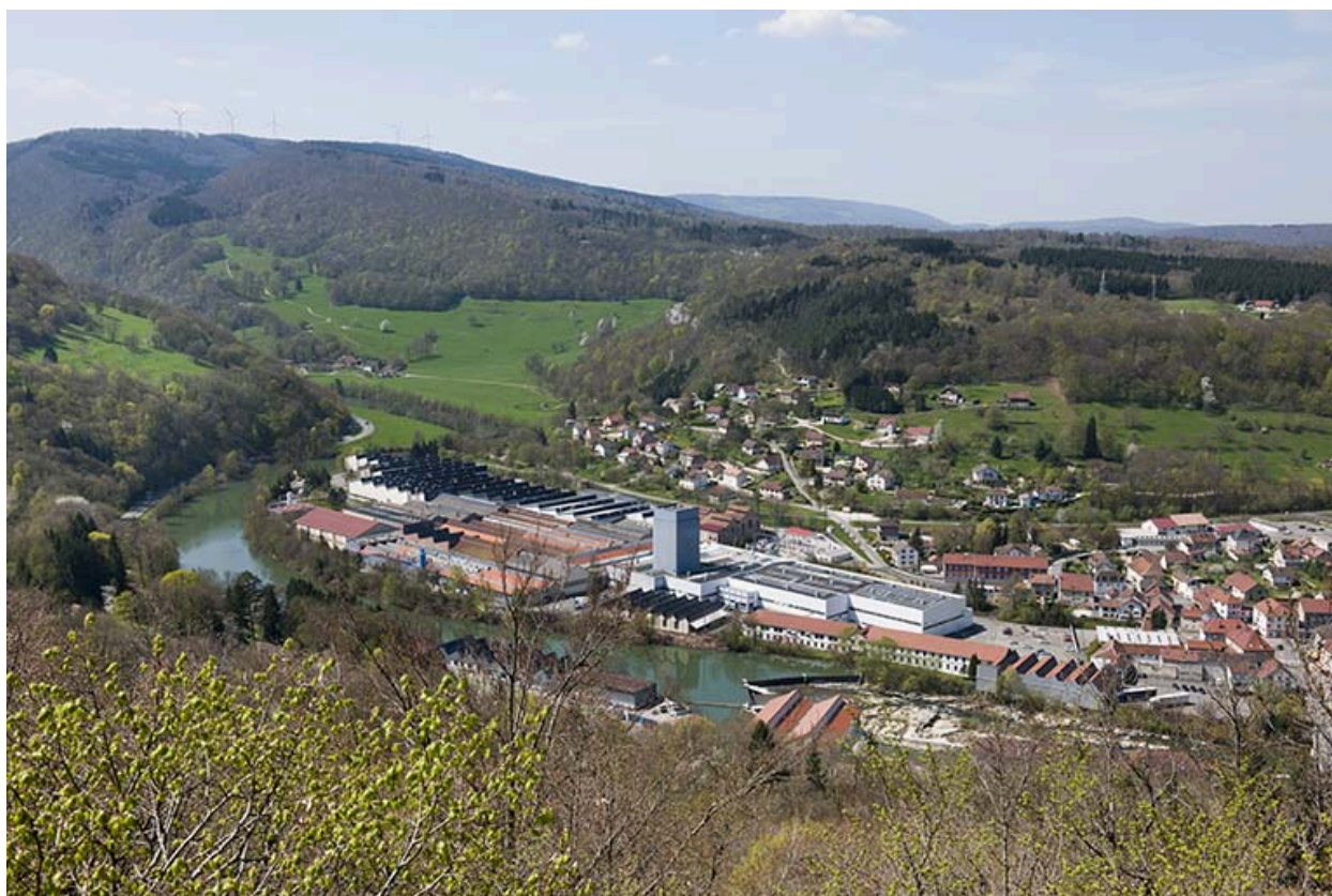
Vue plongeante sur l'usine Aperam (anciennement Peugeot) à Pont-de-Roide.
