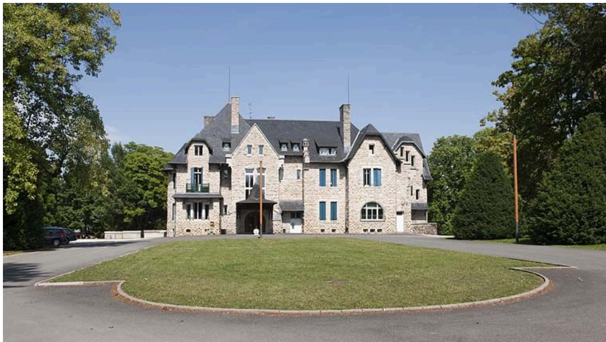
Demeure d'industriel dite château Philippe Bovet à Seloncourt.
