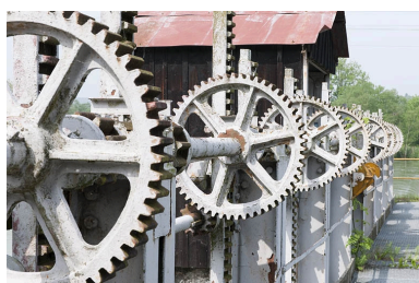
Vannage du barrage de l'usine Peugeot de Baulieu-Mandeure. Phot. Jérôme Mongreville IVR43_20122501096NUC4A
