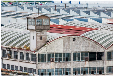
Toitures de l'usine Peugeot de Sochaux-Montbéliard. Phot. Jérôme Mongreville IVR43_20132502780NUC4A
