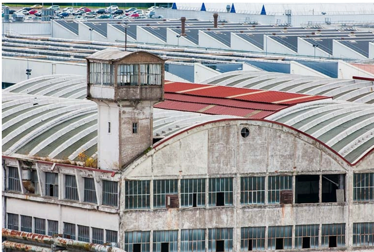
Toitures de l'usine Peugeot de Sochaux-Montbéliard.
