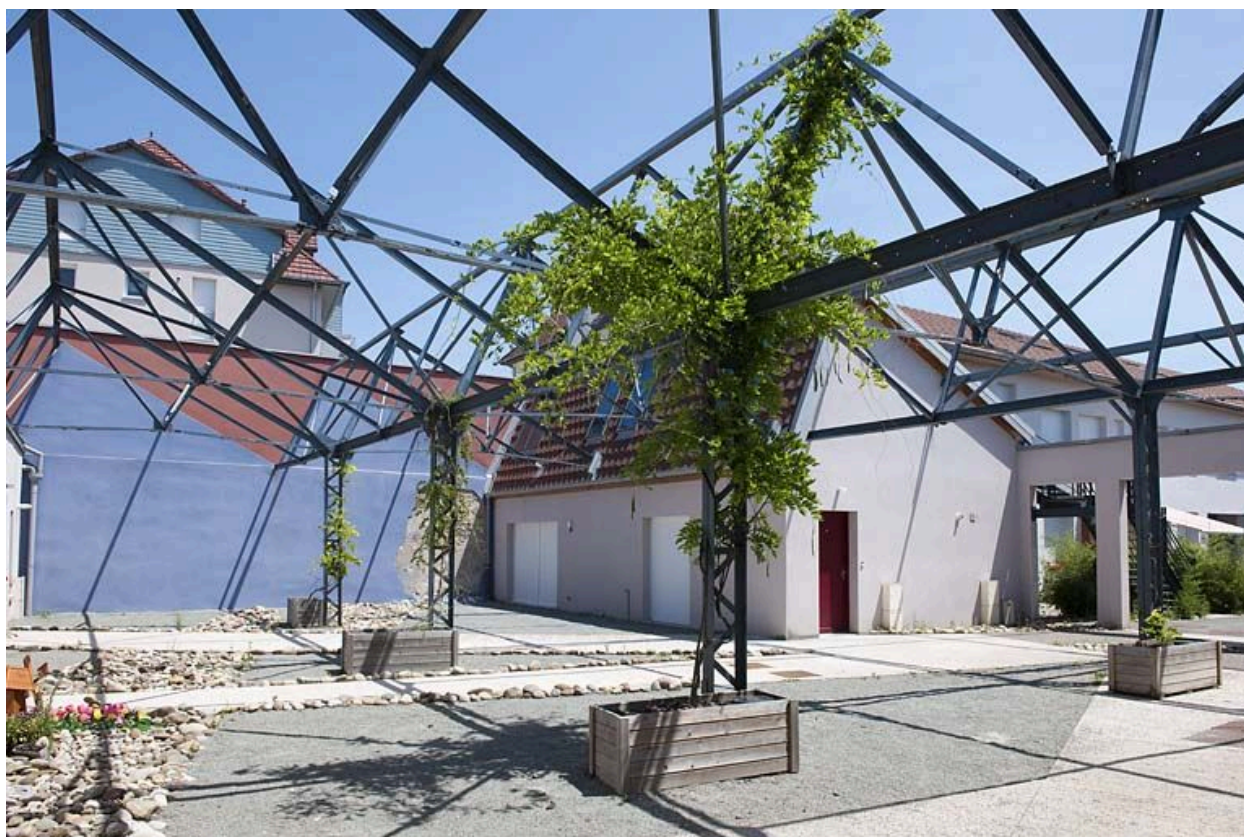
Ancienne usine de matériel d'équipement industriel de la SCEMAS à Seloncourt. Réhabilitaion en logements.
