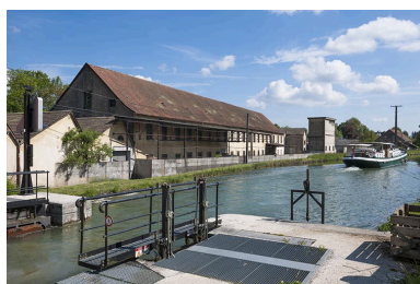
Ancienne usine textile Méquillet-Noblot à Colombier-Fontaine. Phot. Jérôme Mongreville IVR43_20132500442NUC4A
