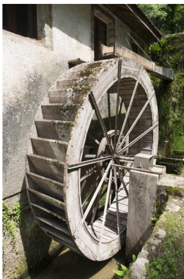
Moulin de la Doue à Abbévillers. Roue hydraulique "en-dessus". Phot. Jérôme Mongreville IVR43_20112501291NUC4A
