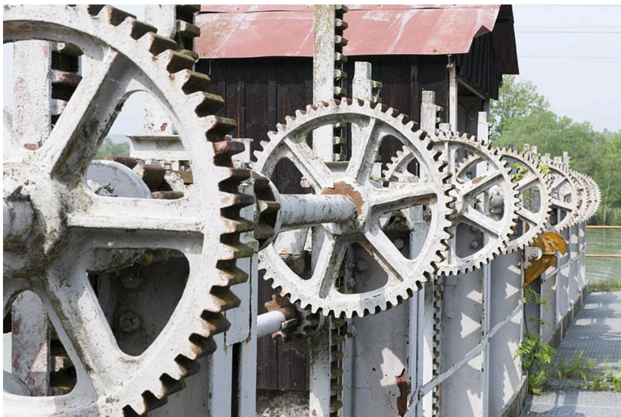
Vannage du barrage de l'usine Peugeot de Baulieu-Mandeure.
