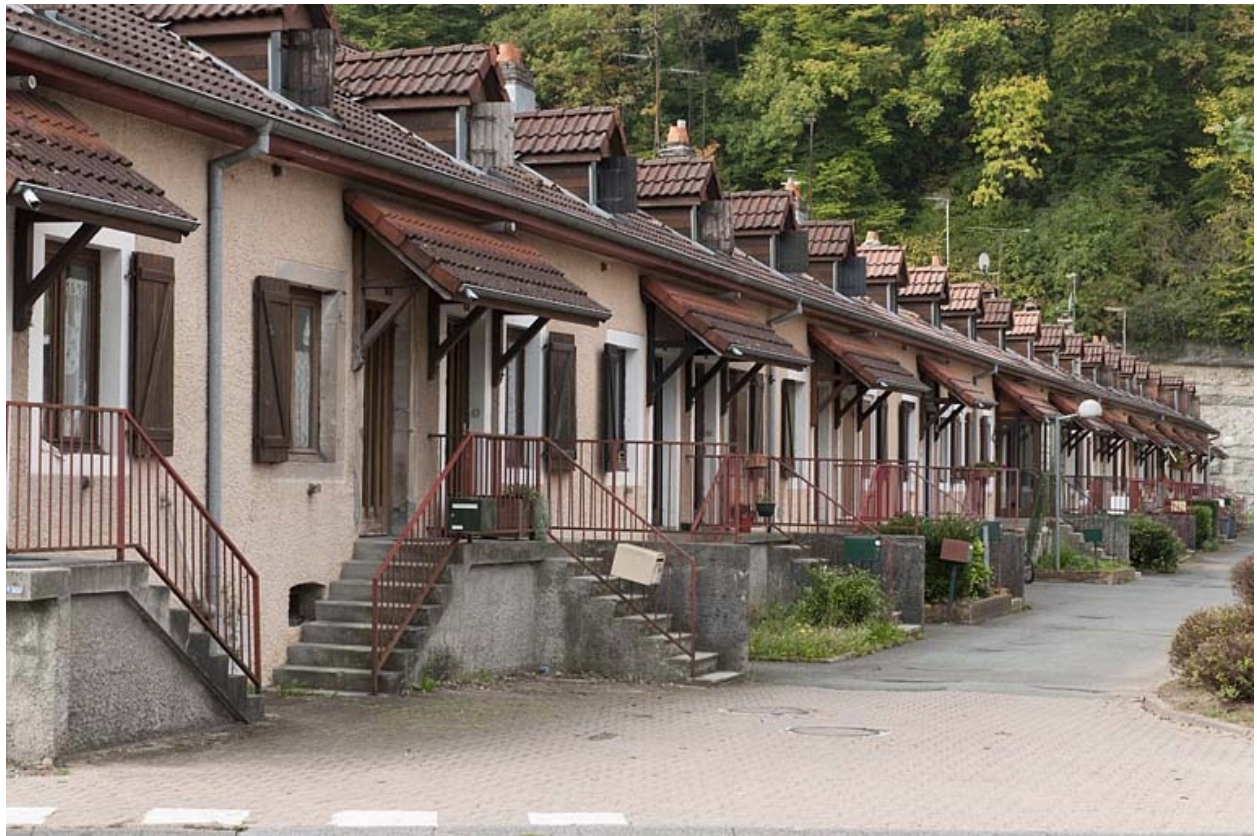
Cité ouvrière de l'usine de Terre-Blanche à Hérimoncourt.
