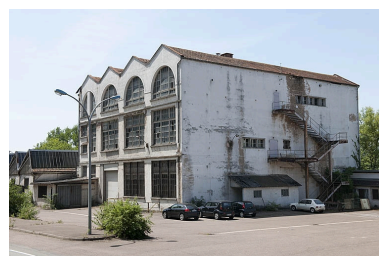
Usine Peugeot Frères "Sur les Roches" à Valentigney. Atelier des presses. Phot. Jérôme Mongreville IVR43_20112501557NUC4A
