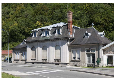
Cercle de l'usine Peugeot de Beaulieu-Mandeure. Phot. Jérôme Mongreville IVR43_20112502268NUC4A
