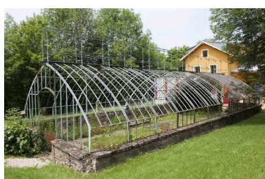
Serre du château Eugène Peugeot à Hérimoncourt. Phot. Jérôme Mongreville IVR43_20112501318NUC4A
