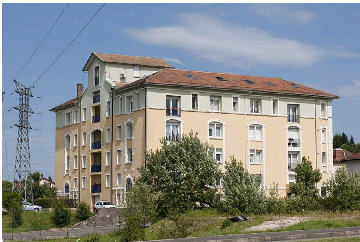
Sous-station électrique à Etupes.
