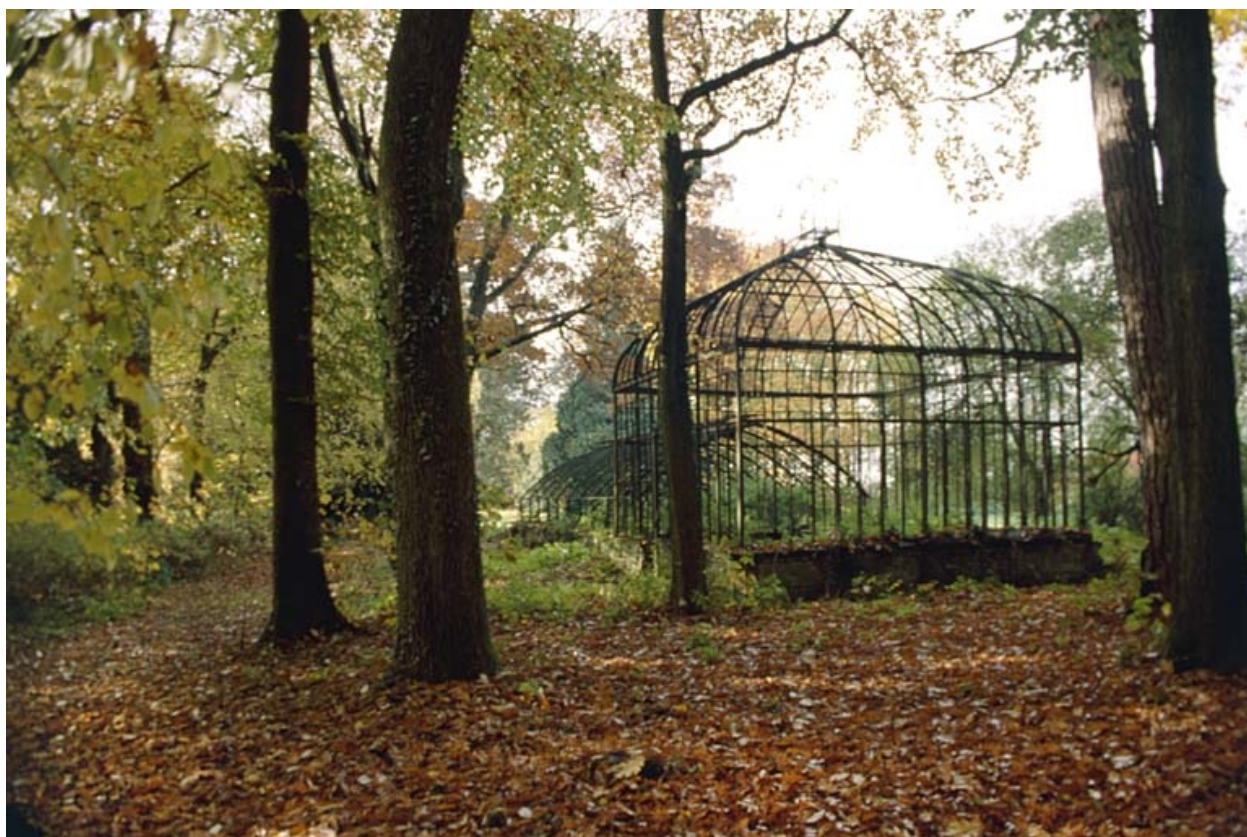
Vue d'ensemble de la serre.
