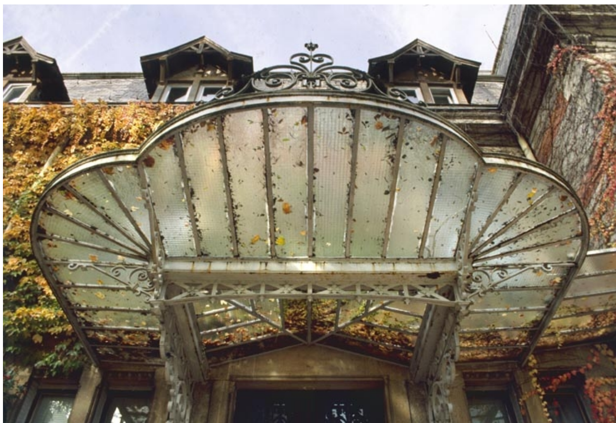
Marquise de la façade sud.
