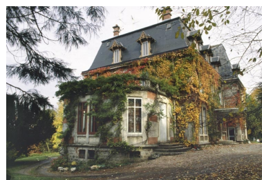
Vue depuis le sud-ouest. Phot. Yves Sancey IVR43_20009000839ZA
