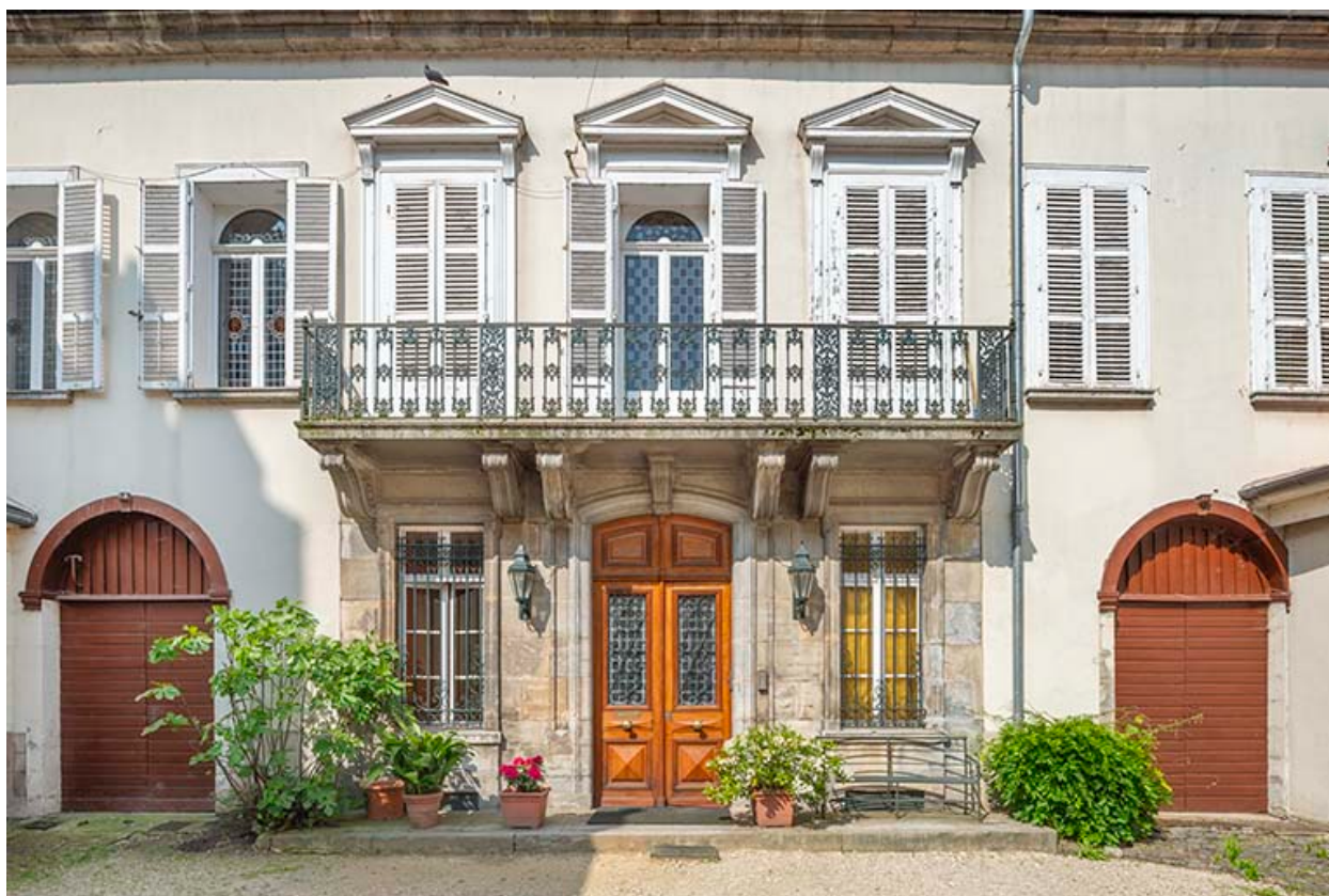
Façade est. Détail de la partie centrale.
