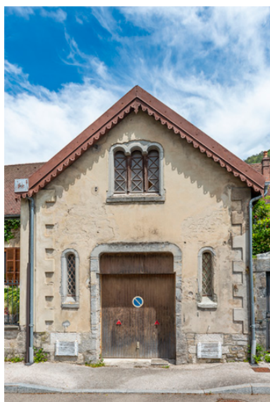
Remise nord (quai Valette). Phot. Jérôme Mongreville IVR43_20233900694NUC4A
