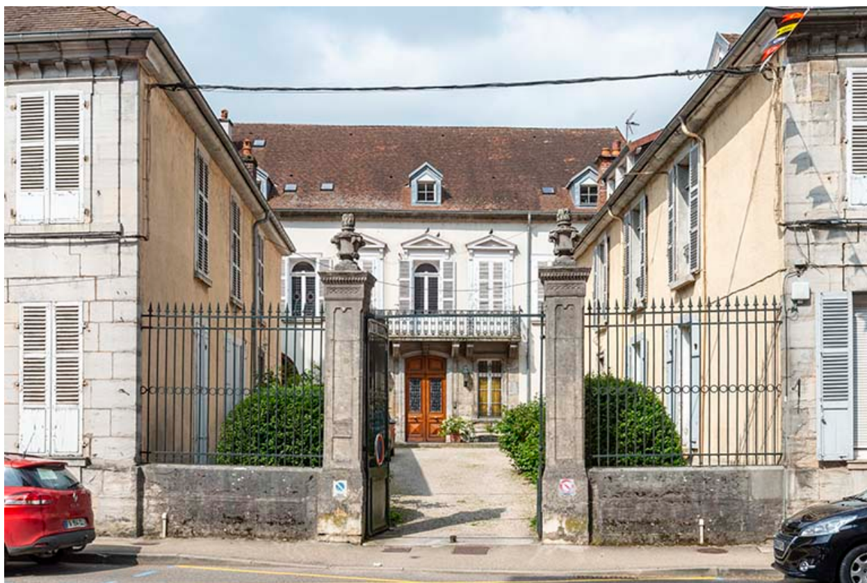
Vue de la cour depuis l'est.
