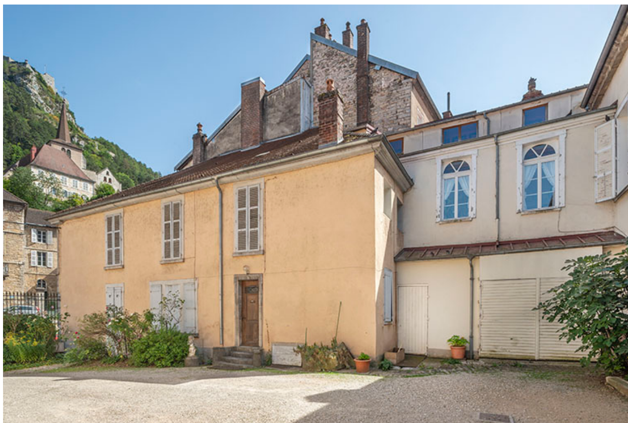
Pavillon sud. Vue de trois quarts.
