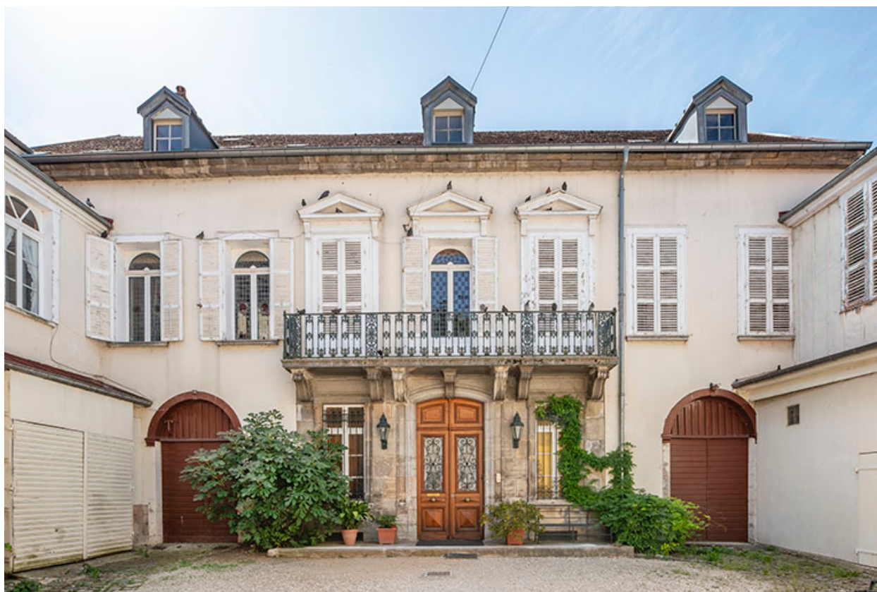
Façade sur cour. Vue de face.
