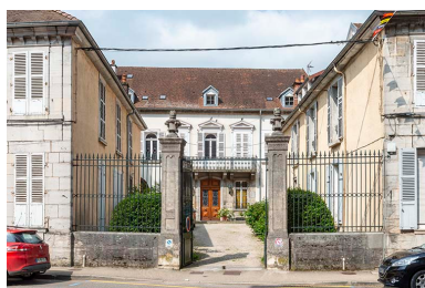
Vue de la cour depuis l'est. Phot. Jérôme Mongreville IVR43_20233900841NUC4A
