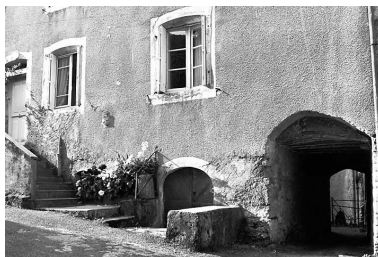
Vue du rez-de-chaussée. Phot. Yves Sancey IVR43_19777000425X
