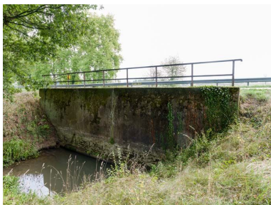
Vue de l'aqueduc.
