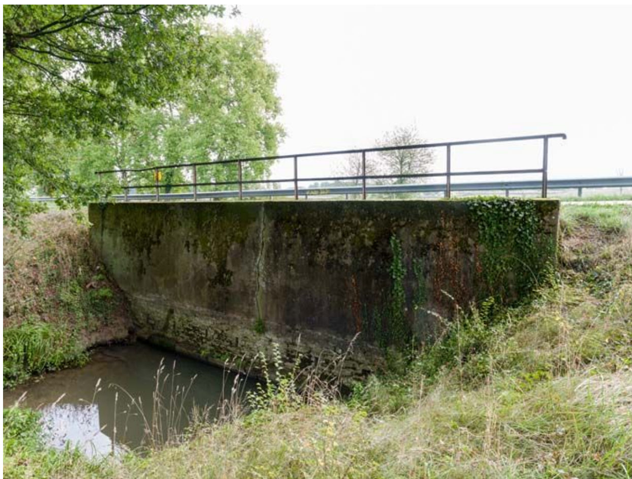
Vue de l'aqueduc.
