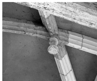
Choeur, détail : clef de voûte. Phot. Michel Thierry IVR26_19748900778X
