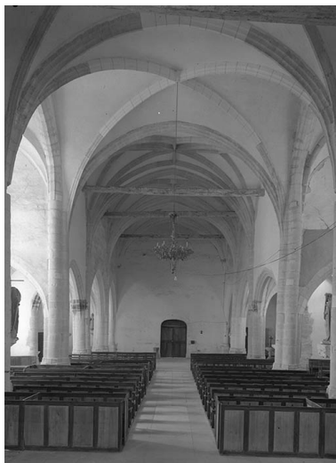
Nef vue depuis le choeur. Phot. Michel Thierry IVR26_19748900770V
