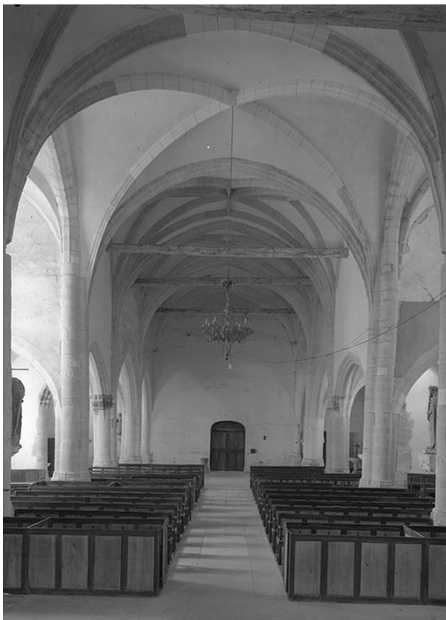
Nef vue depuis le chœur.
