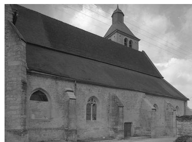
Façade du bas-côté nord. Phot. Michel Thierry IVR26_19748900786V
