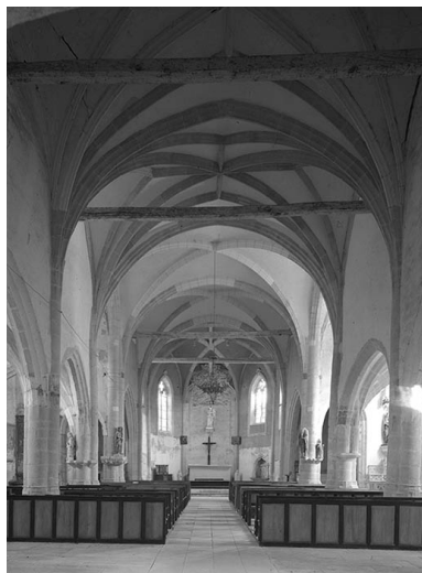
Nef vue depuis le mur antérieur. Phot. Michel Thierry IVR26_19748900772V
