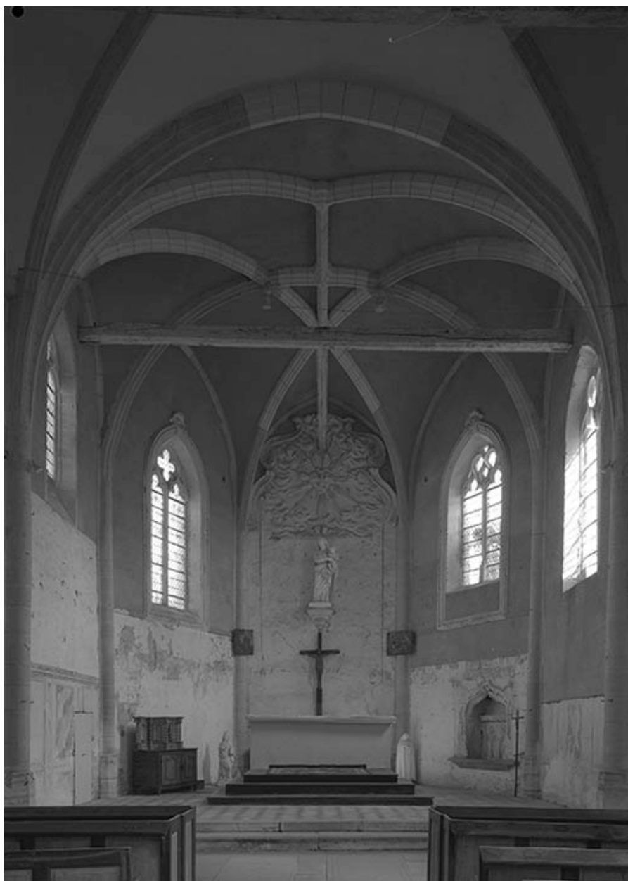
Choeur avec voûte d'ogives. Peinture monumentale.
