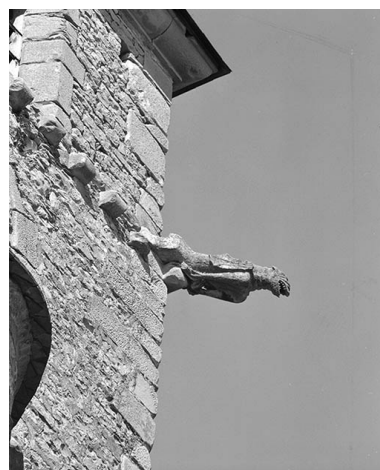
Façade droite du choeur, détail : gargouille droite. Phot. Michel Thierry IVR26_19748900790X
