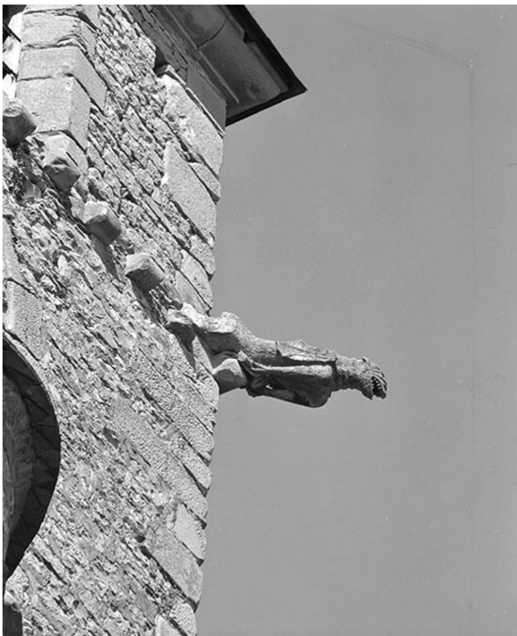
Façade droite du choeur, détail : gargouille droite.
