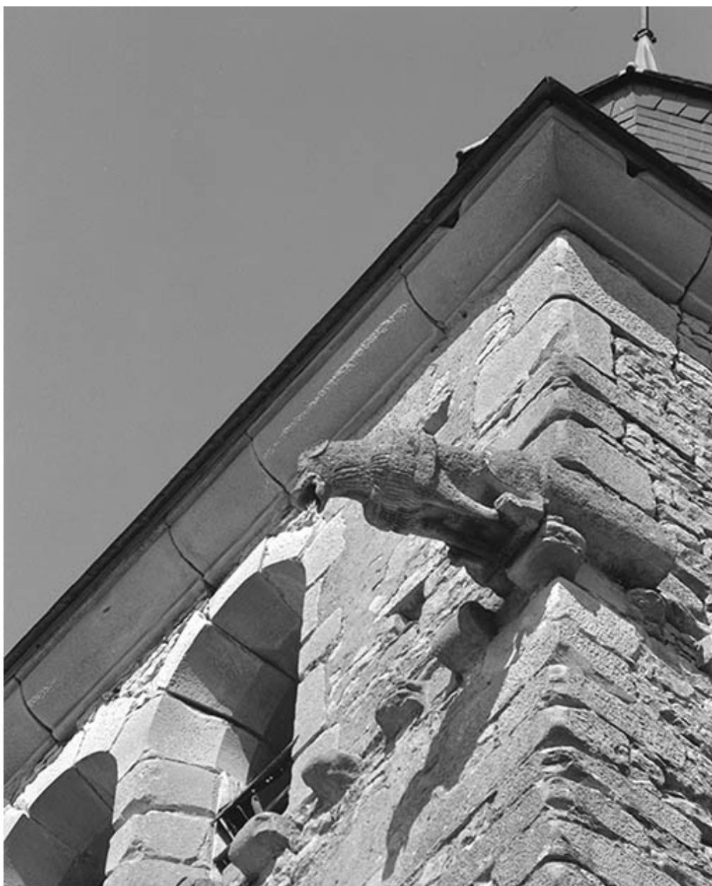
Façade droite du choeur, détail : gargouille gauche.
