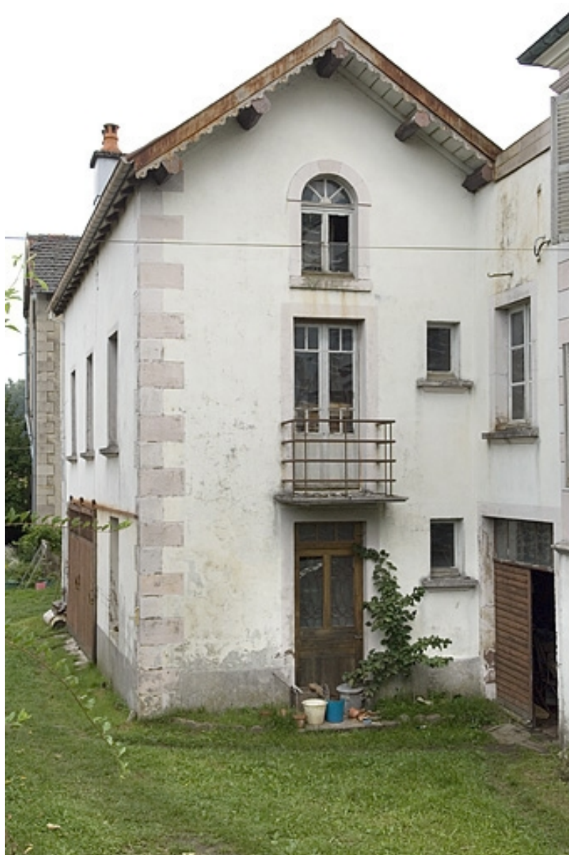
Garage, écurie et logement. Pignon du bâtiment.
