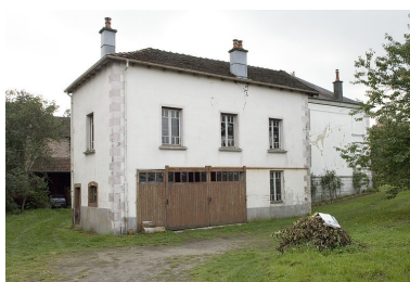
Garage, écurie et logement. Phot. Jérôme Mongreville IVR43_20067000687NUCA
