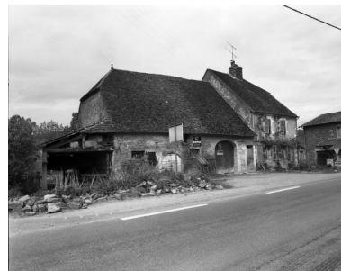
Ferme située rue Désiré Monnier : vue d'ensemble. Phot. Yves Sancey IVR43_19813900248X
