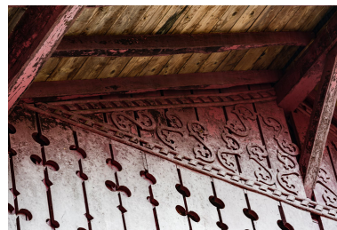
Placage de planches en bois ajourées et sculptées du pignon, détail de la partie gauche. Phot. Pierre-Marie Barbe-Richaud IVR26_20195800594NUC4A
