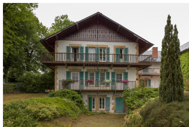
Façade du corps principal, vue de face. Phot. Pierre-Marie Barbe-Richaud IVR26_20195800591NUC4A
