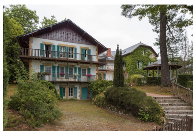
Vue depuis le sud-ouest avec l'aile en retour à droite. Phot. Pierre-Marie Barbe-Richaud IVR26_20195800590NUC4A
