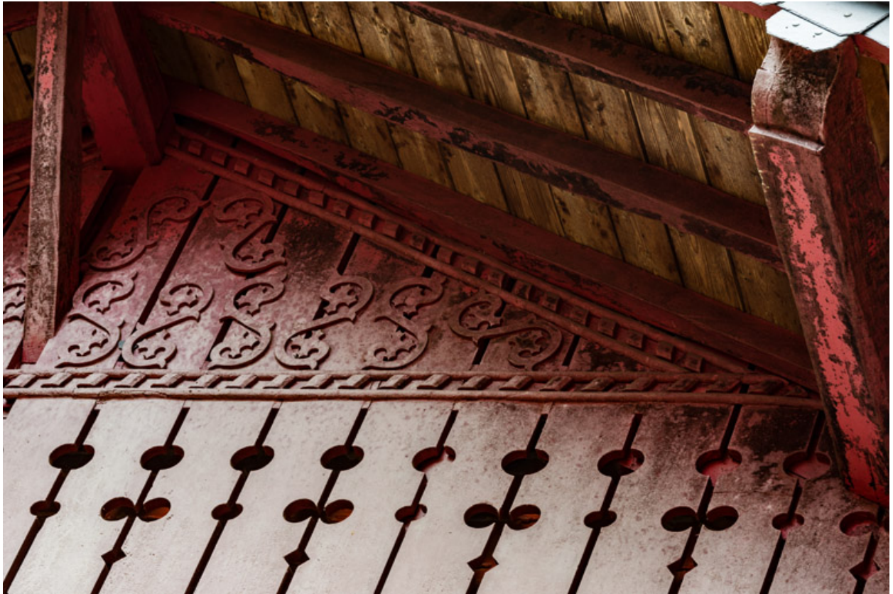
Placage de planches en bois ajourées et sculptées du pignon, détail de la partie droite.
