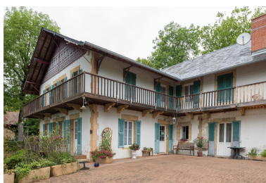
Vue depuis le sud-est avec l'aile en retour à droite. Phot. Pierre-Marie Barbe-Richaud IVR26_20195800595NUC4A
