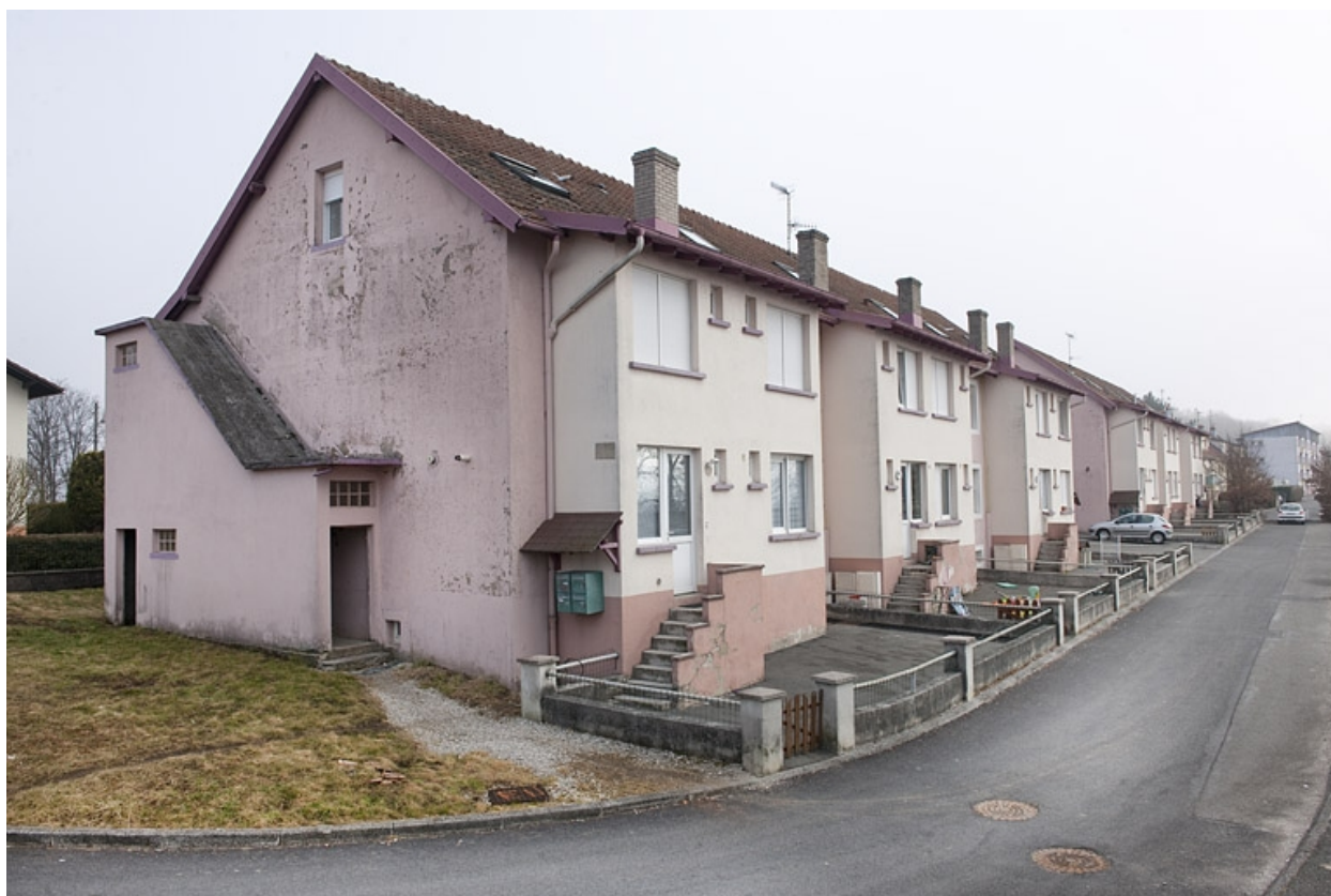
Immeubles d'habitation vus depuis l'ouest.
