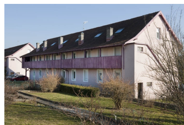
Immeuble d'habitation vu de trois quarts arrière.. Phot. Jérôme Mongreville IVR43_20122500140NUC4A
