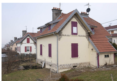
Façades sud des maisons jumelées impasse Bellevue. Phot. Jérôme Mongreville IVR43_20122500134NUC4A
