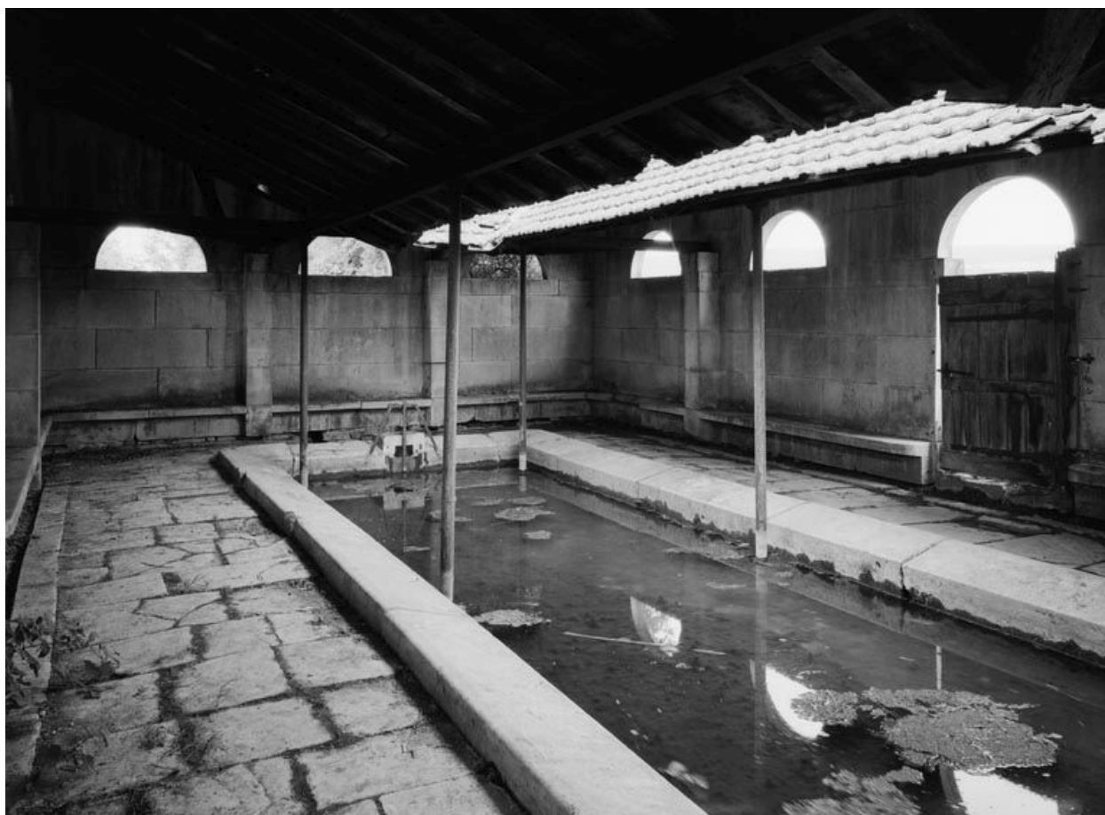
Vue intérieure du lavoir.
