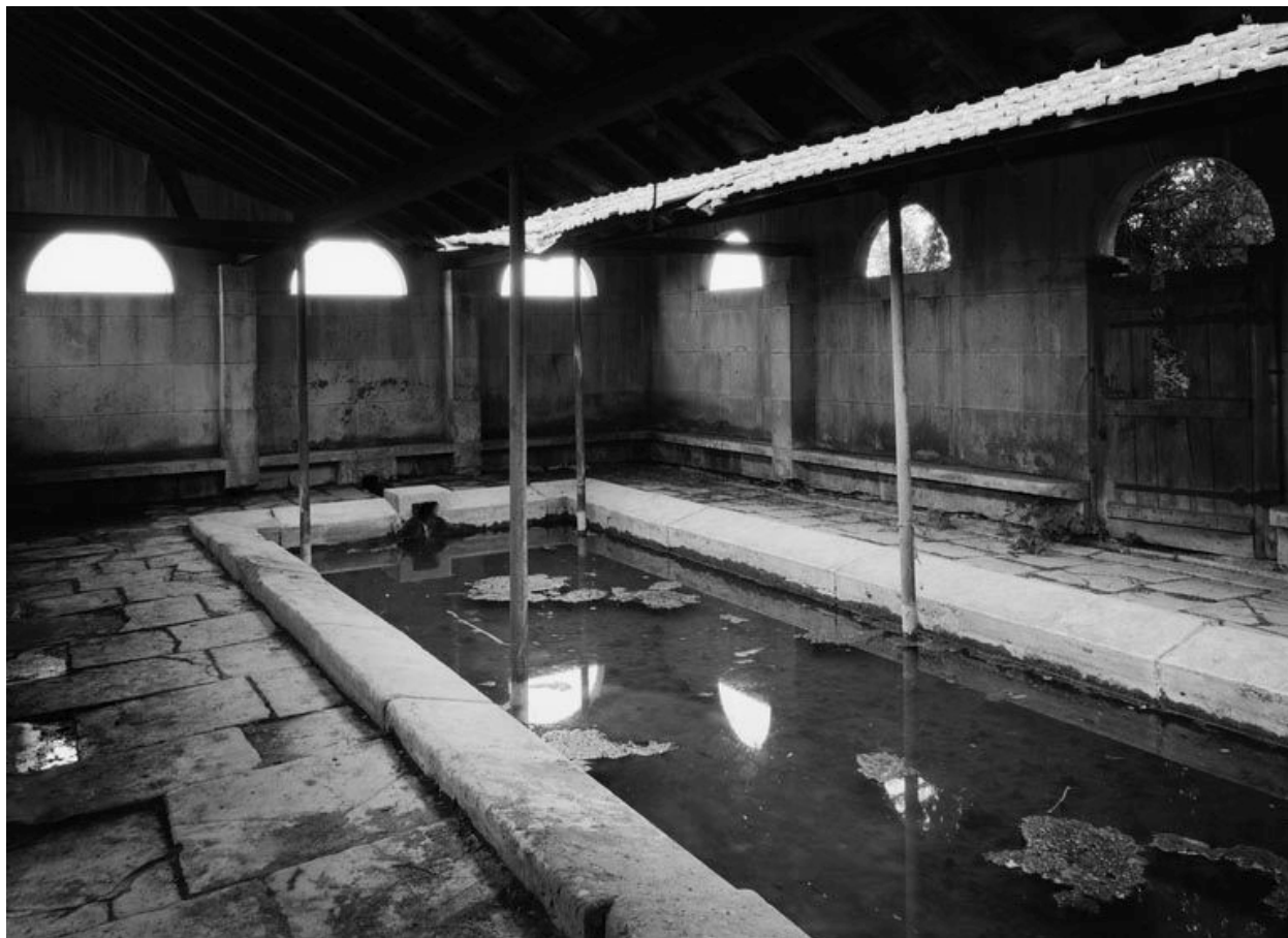
Vue intérieure du lavoir.
