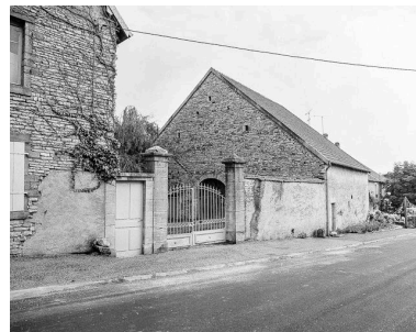
Partie agricole. Phot. Dominique Dominguez IVR43_19807000245X
