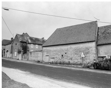
Vue générale depuis la rue. Phot. Dominique Dominguez IVR43_19807000243X
