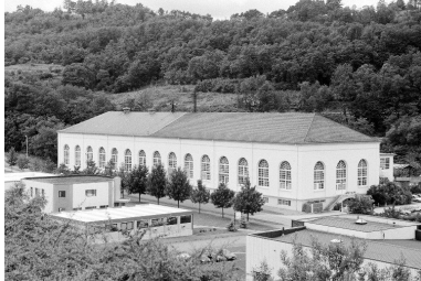
La salle des machines de l'ancienne station centrale vue du sud-est.
