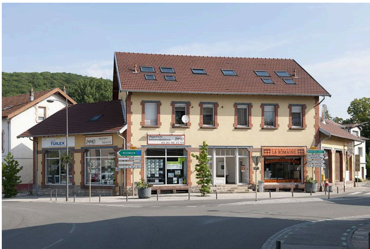
Façade antérieure et dépendances latérales.
