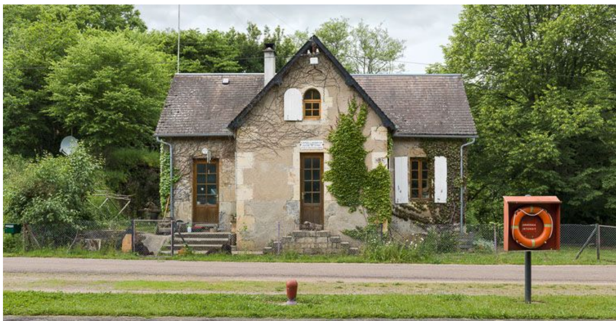
Vue de face de la maison éclusière.
