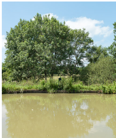
Vue du déversoir.
