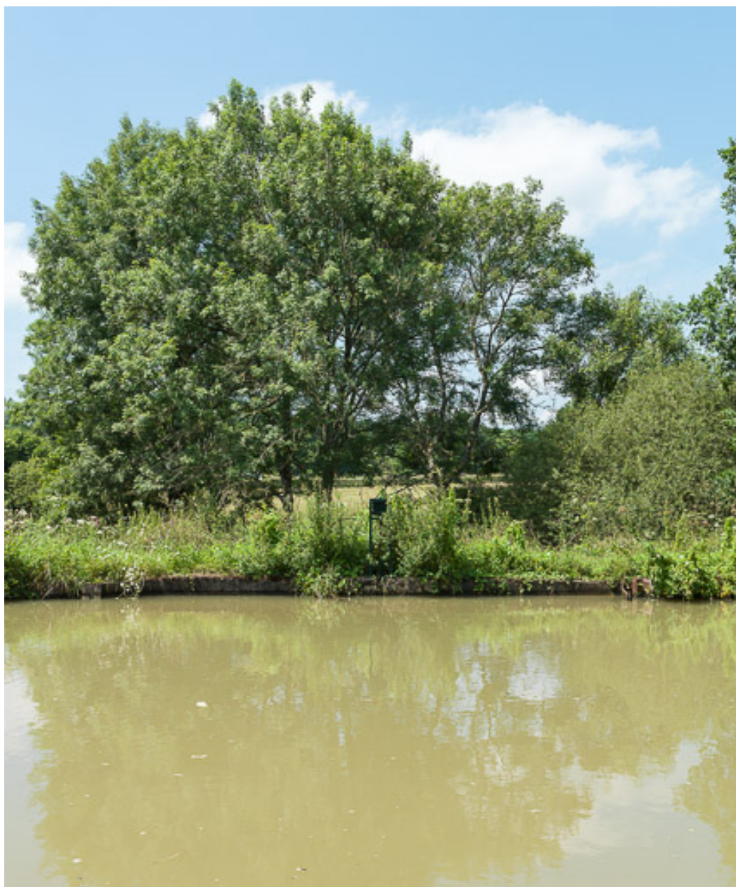
Vue du déversoir.
