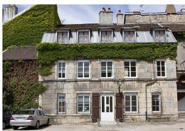
Troisième logis secondaire, façade antérieure : de face.
