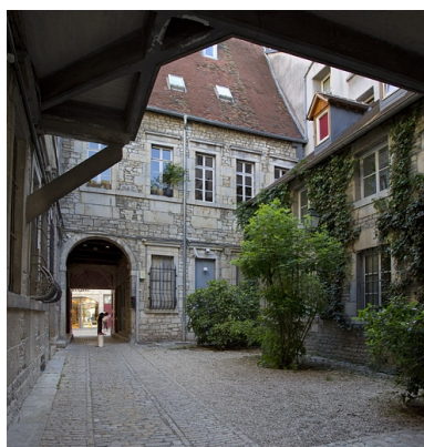
Logis principal : aile sur rue, façade postérieure. Phot. Yves Sancey IVR43_20112500935NUC2A
