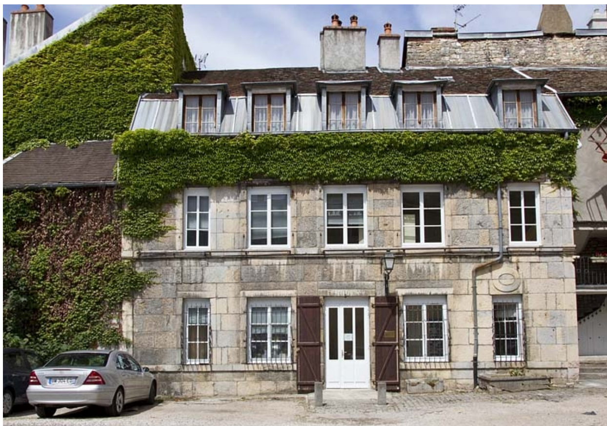
Troisième logis secondaire, façade antérieure : de face.
