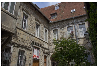
Logis principal : façades sur cour. Phot. Yves Sancey IVR43_20112500934NUC2A
