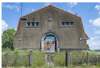
Face antérieure. Phot. Jérôme Mongreville IVR43_20217000320NUC4A
