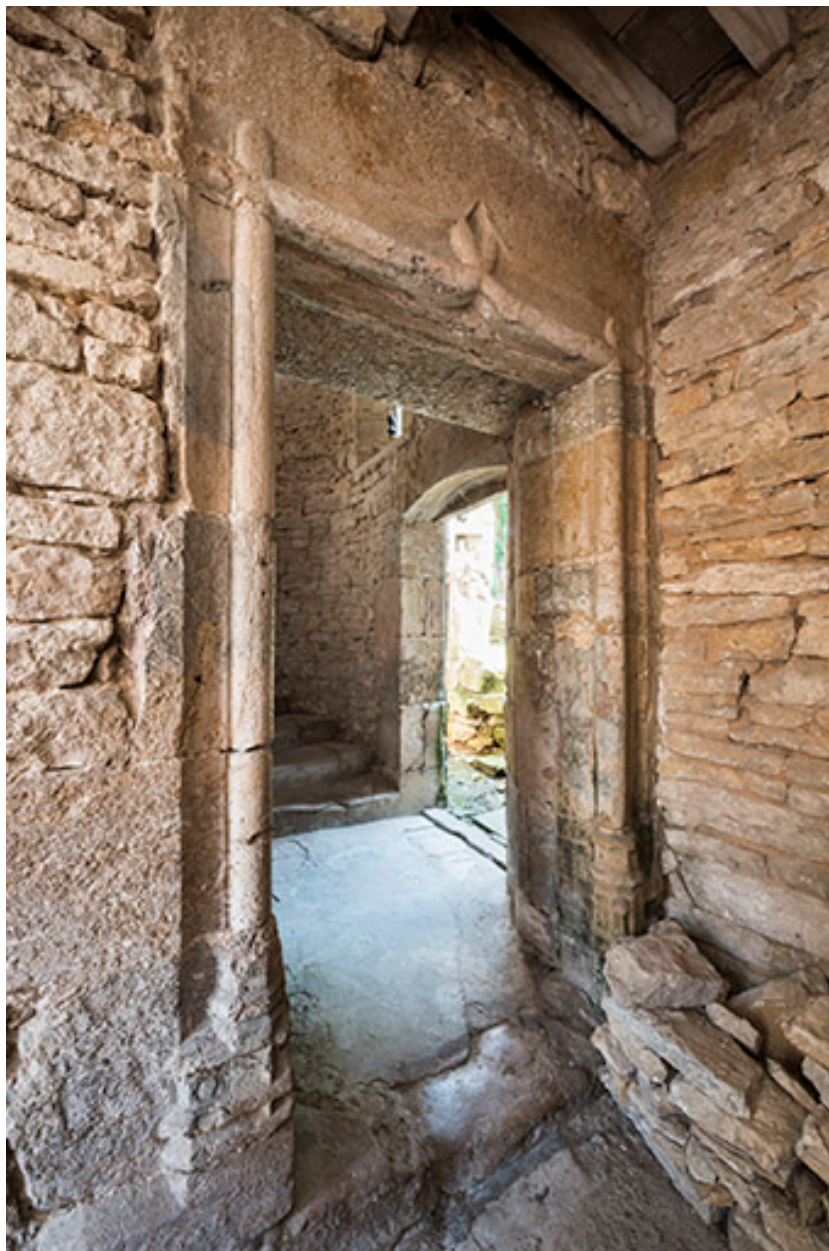
Porte d'accès vers l'escalier de l'ancien prieuré.
