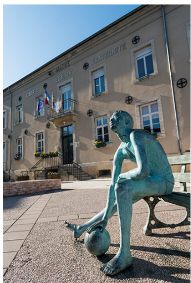
Façade principale de la mairie. Phot. Sonia Dourlot IVR43_20157000200NUC4A
