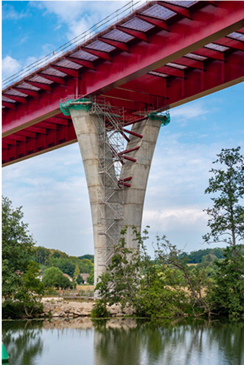
Le viaduc de la déviation de Port-sur-Saône en construction.
