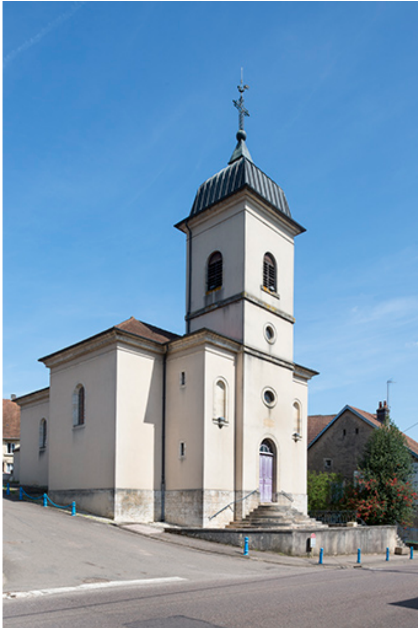
La chapelle depuis la rue Saint-Valère.
