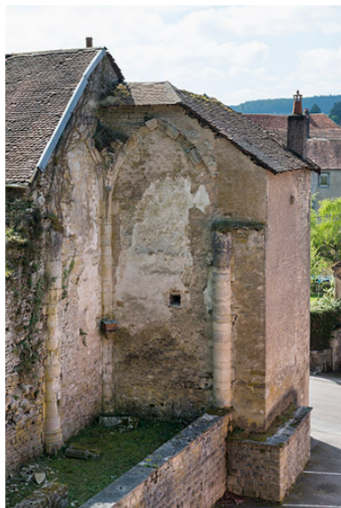
Vestiges de l'ancienne église, rue de l'Eglise. Phot. Jérôme Mongreville IVR43_20177000712NUC4A
