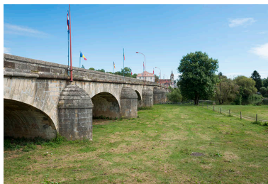
Le pont en pierre. Phot. Jérôme Mongreville IVR43_20177001050NUC4A
