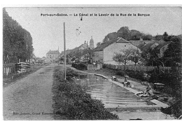
Le lavoir rue de la Barque, carte postale. IVR43_20177000897NUC1A
