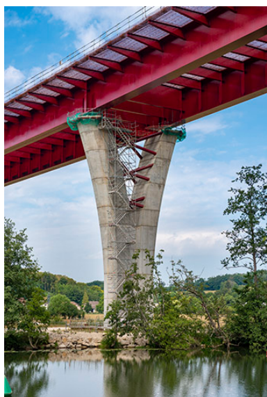
Le viaduc de la déviation de Port-sur-Saône en construction. Phot. Jérôme Mongreville IVR43_20207000205NUC4A
