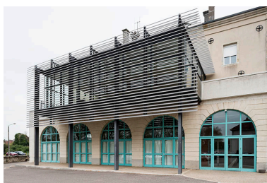
Façade postérieure de l'hôtel de ville. Phot. Jérôme Mongreville IVR43_20177000689NUC4A
