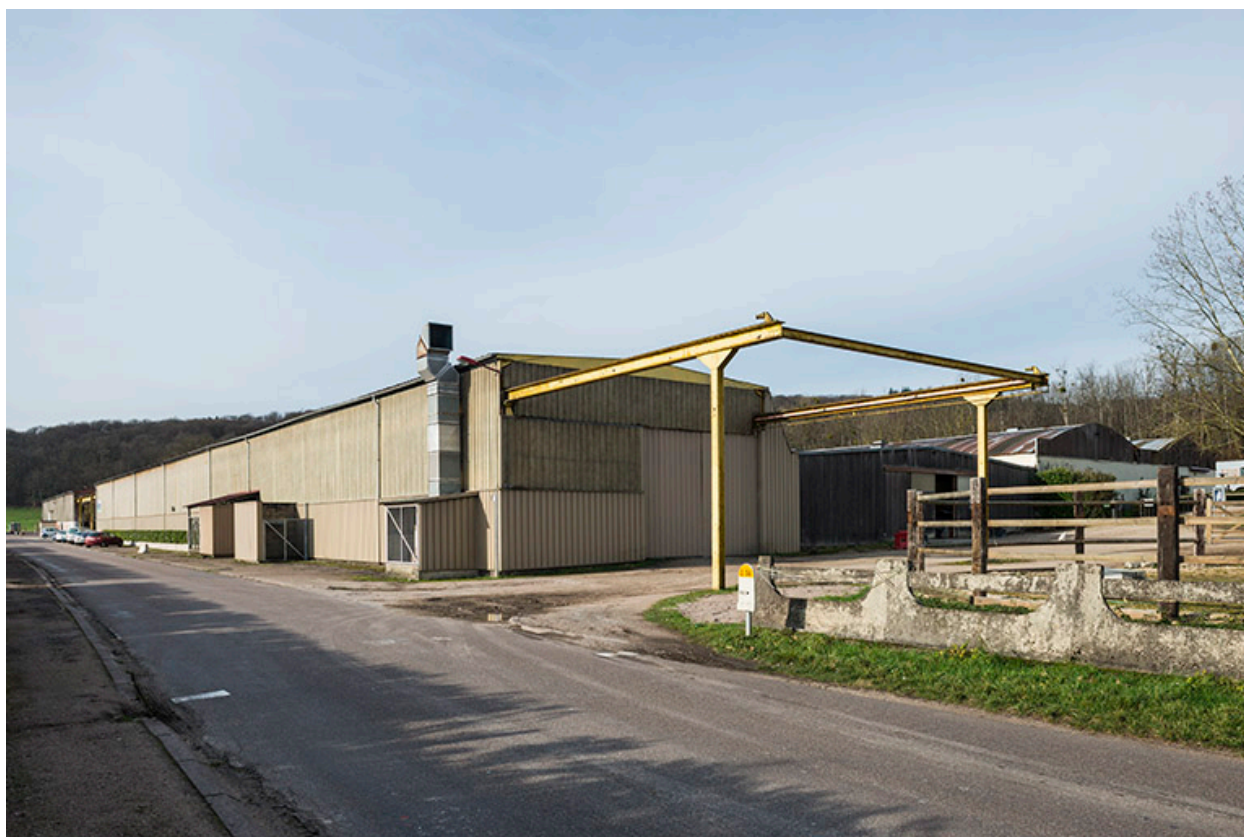
Hangar de la société Selam, route de Ferrières.
