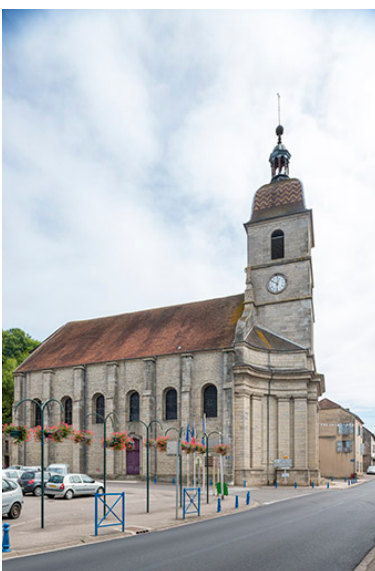
Vue d'ensemble de l'église Saint-Etienne. Phot. Jérôme Mongreville IVR43_20177000977NUC4A
