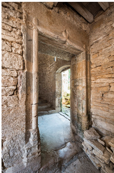
Porte d'accès vers l'escalier de l'ancien prieuré. Phot. Jérôme Mongreville IVR43_20177000845NUC4A
