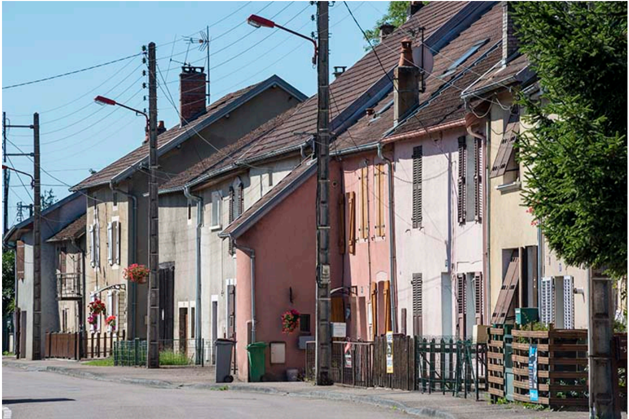
Maisons et anciennes fermes, rue du Magny.
