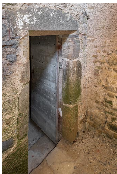
Porte chanfreinée donnant accès à la galerie et qui était vraisemblablement la porte d'entrée d'origine de la maison. Phot. Pierre-Marie Barbe-Richaud IVR26_20197100758NUC4A
