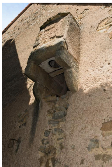
Latrine (mur pignon ouest de la maison Mommessin) Phot. Pierre-Marie Barbe-Richaud IVR26_20187100169NUC4A
