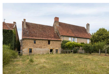
Vue de la façade postérieure de la maison Mommessin Phot. Pierre-Marie Barbe-Richaud IVR26_20187100166NUC4A
