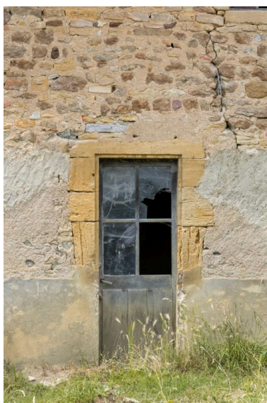
Porte (ancienne fenêtre) sur la façade postérieure de la maison, portant la date de 1691 Phot. Pierre-Marie Barbe-Richaud IVR26_20187100167NUC4A
