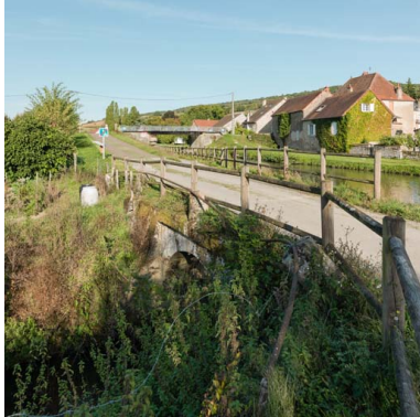
Vue de l'aqueduc.
