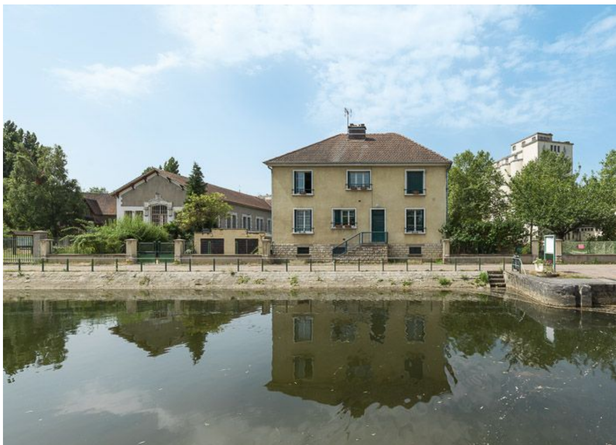
Vue de la maison éclusière, de face.
