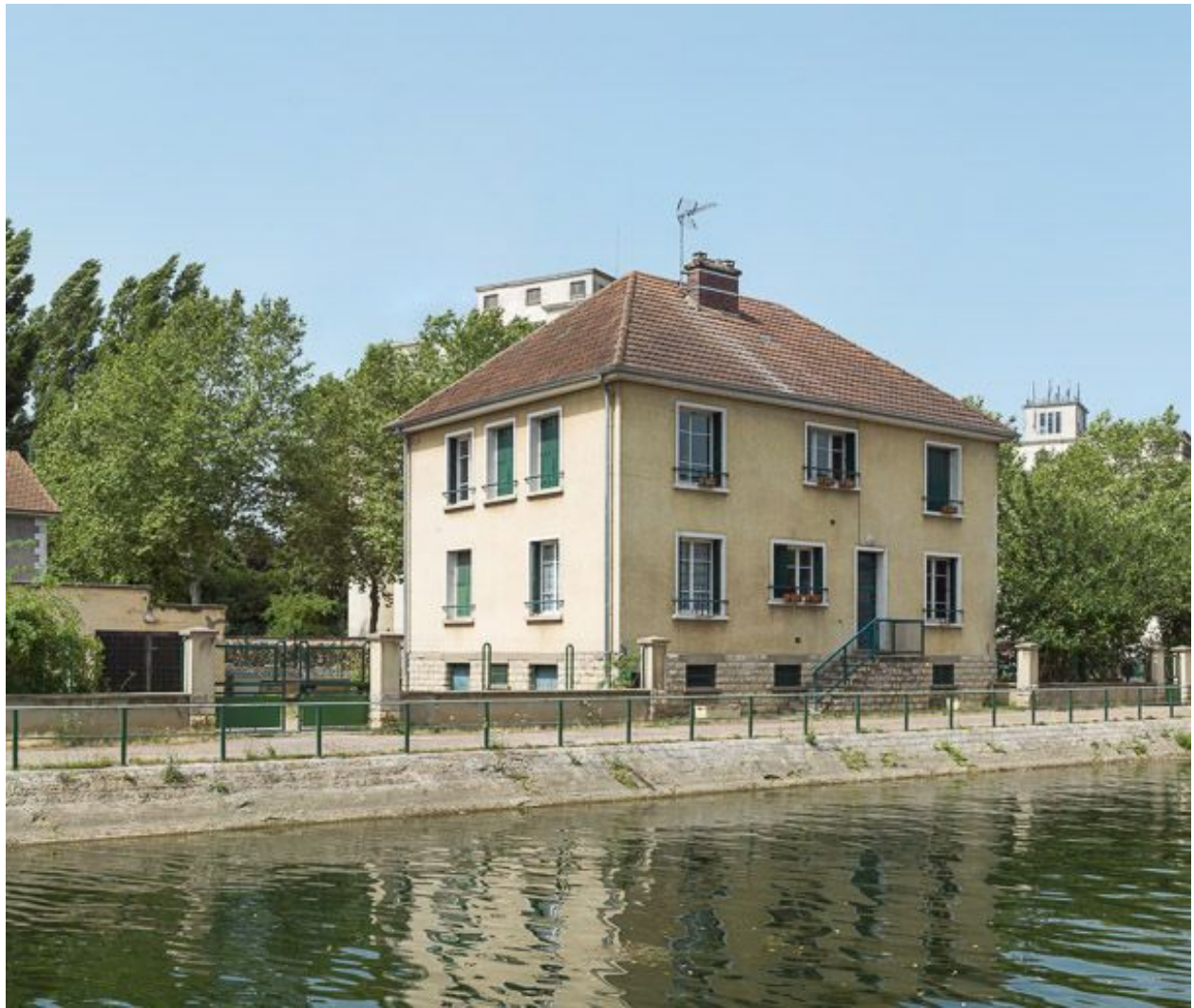
La maison éclusière, vue de 3/4.
