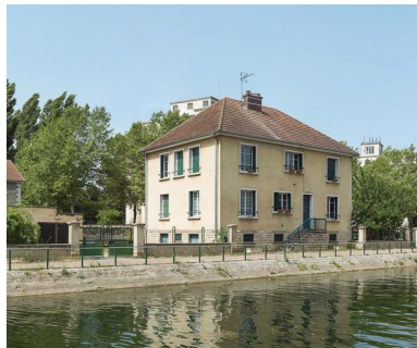
La maison éclusière, vue de 3/4. Phot. Pierre-Marie Barbe-Richaud IVR26_20138900160NUC4AQ
