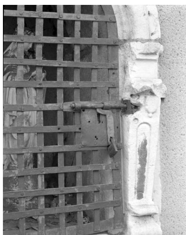
Détail d'une niche sur la façade latérale droite : système de fermeture. Phot. Yves Sancey IVR43_19947000040X
