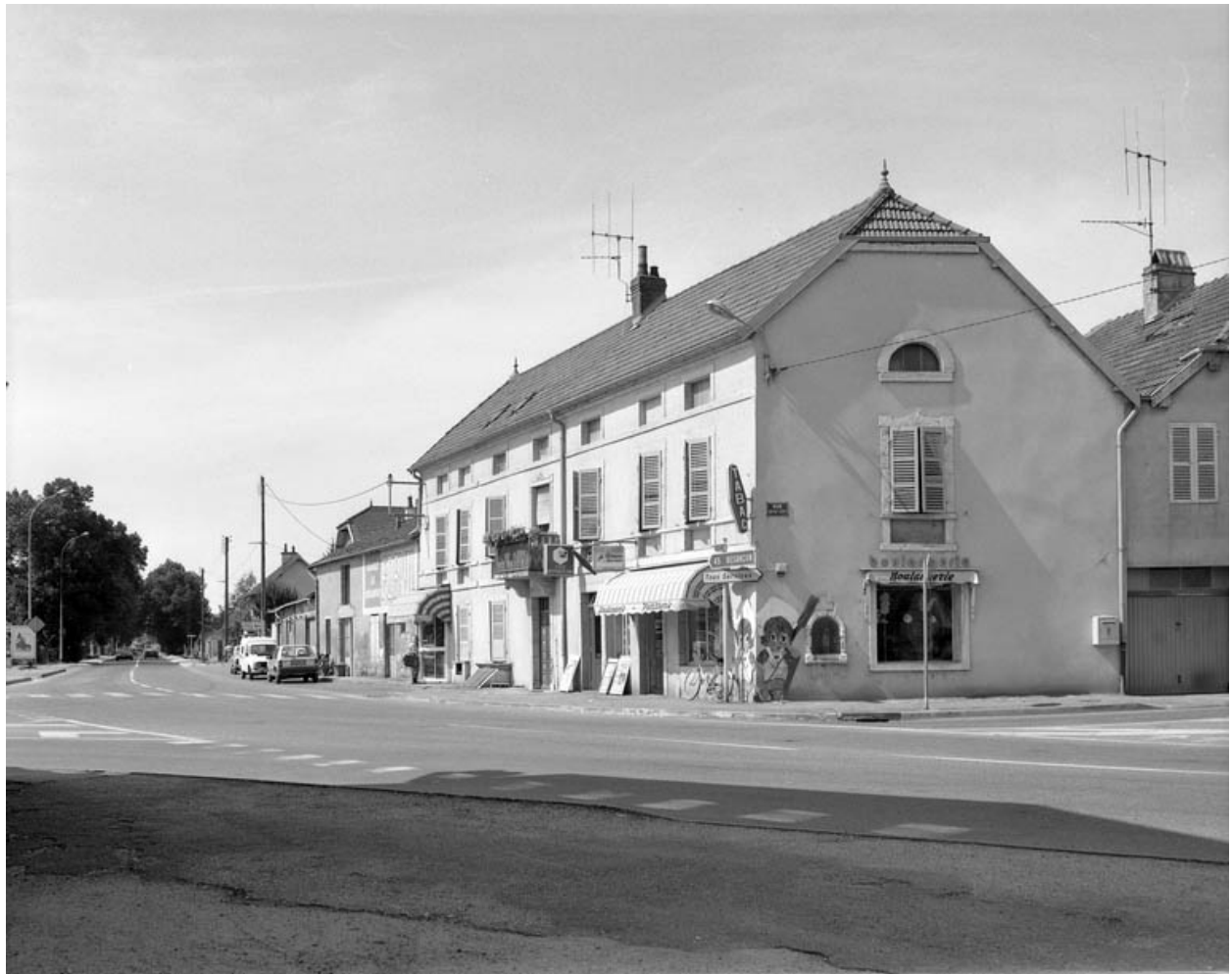
Façades antérieures et latérale droite.
