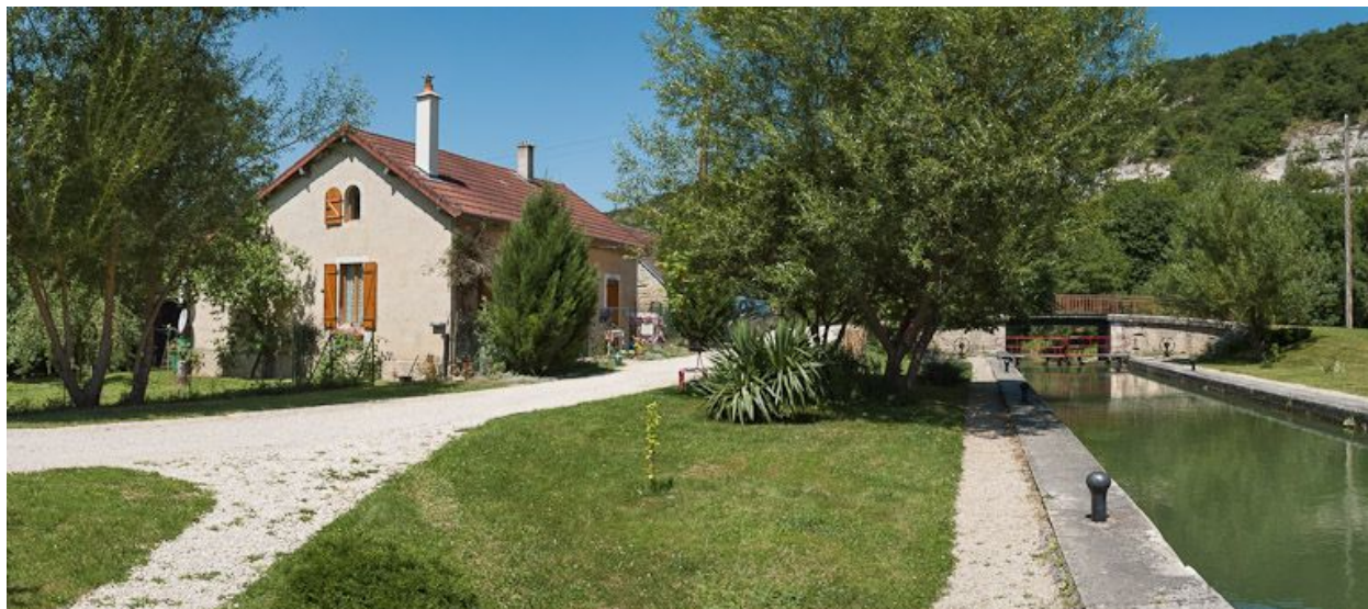
Le site d'écluse vu du sas.
