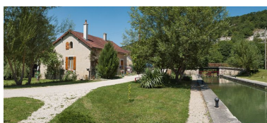
Le site d'écluse vu du sas. Phot. Pierre-Marie Barbe-Richaud IVR26_20128900360NUC4AQ
