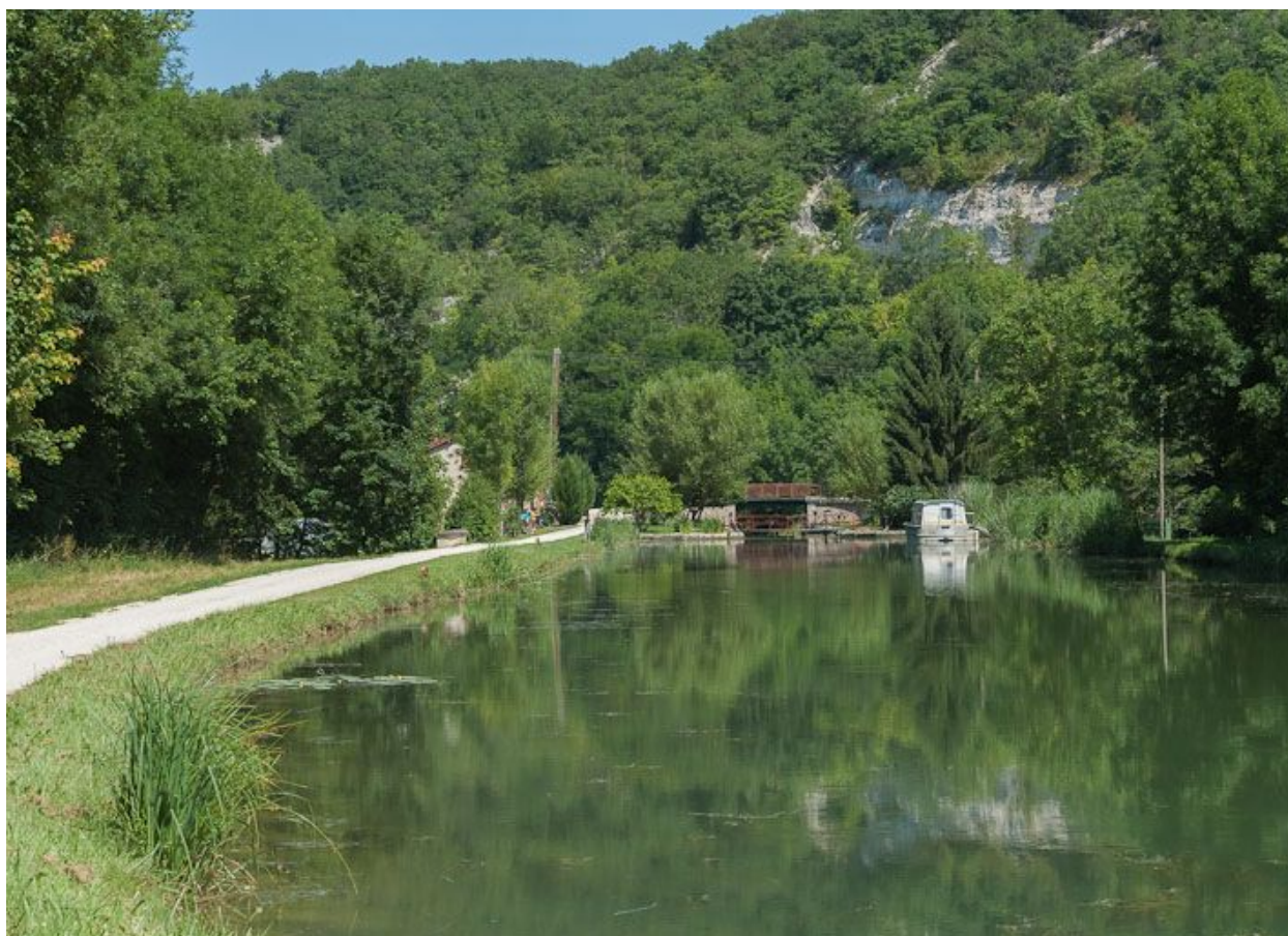
Le site d'écluse vu d'amont.
