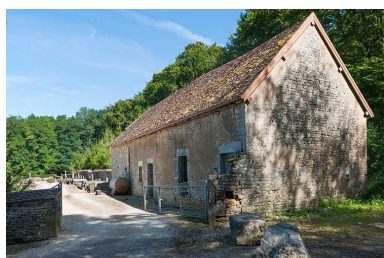
Ancienne ferme située au sud-ouest du cimetière Phot. Jérôme Mongreville IVR43_20137000185NUCA
