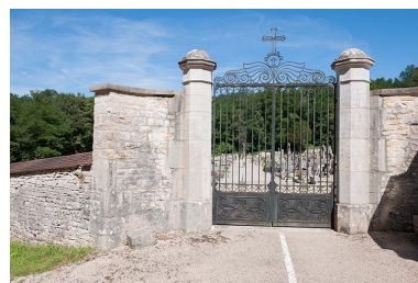
Portail d'entrée Phot. Jérôme Mongreville IVR43_20137000178NUCA
