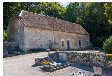
Ancienne ferme située au sud-ouest du cimetière Phot. Jérôme Mongreville IVR43_20137000184NUCA
