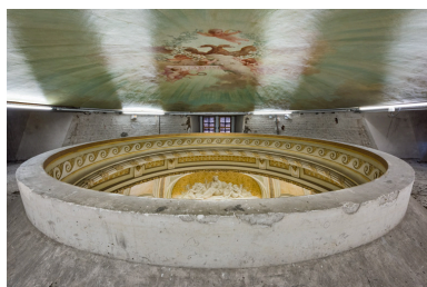
Oculus zénithal de la coupole et intrados peint de la calotte. Phot. Pierre-Marie Barbe-Richaud IVR26_20257100250NUC4A
