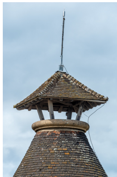
Toiture : petit toit en pavillon coiffant l'oculus zénithal. Phot. Pierre-Marie Barbe-Richaud IVR26_20257100256NUC4A
