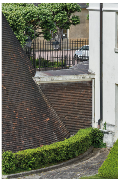
Corps de jonction avec l'aile de la Marine : élévation postérieure. Phot. Pierre-Marie Barbe-Richaud IVR26_20257100258NUC4A
