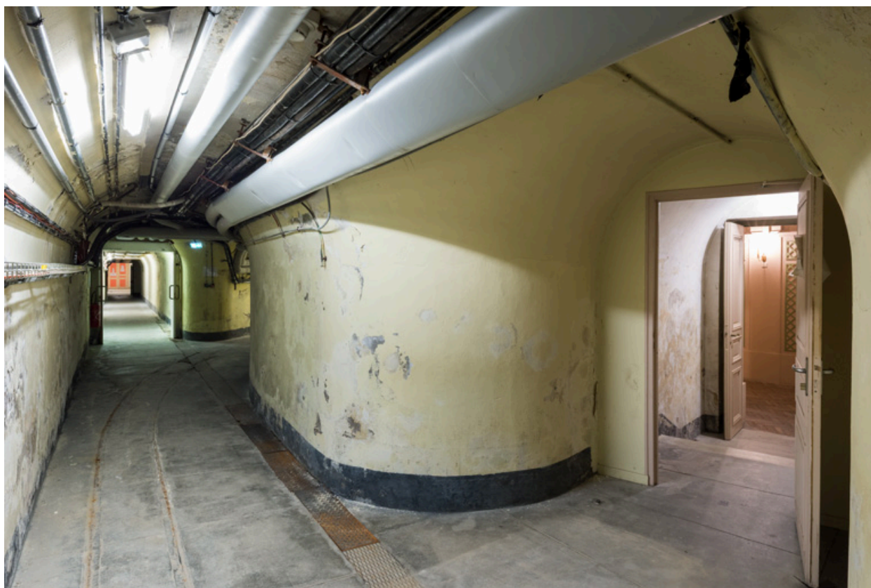
Sous-sol : couloir souterrain, avec à droite l'accès au théâtre.
