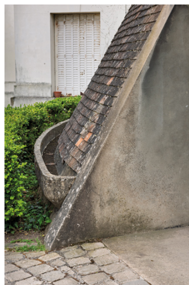
Jardinière à la base de la toiture. Phot. Pierre-Marie Barbe-Richaud IVR26_20257100260NUC4A
