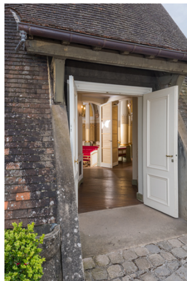
Entrée, côté nord-est. Phot. Pierre-Marie Barbe-Richaud IVR26_20257100261NUC4A
