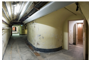
Sous-sol : couloir souterrain, avec à droite l'accès au théâtre. Phot. Pierre-Marie Barbe-Richaud IVR26_20257100333NUC4A
