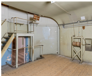
Sous-sol : salle du jeu d'orgue. Estrade du chef d'orchestre au-dessus de la porte et treuil de commande du rideau de scène à droite. Phot. Pierre-Marie Barbe-Richaud IVR26_20257100336NUC4A
