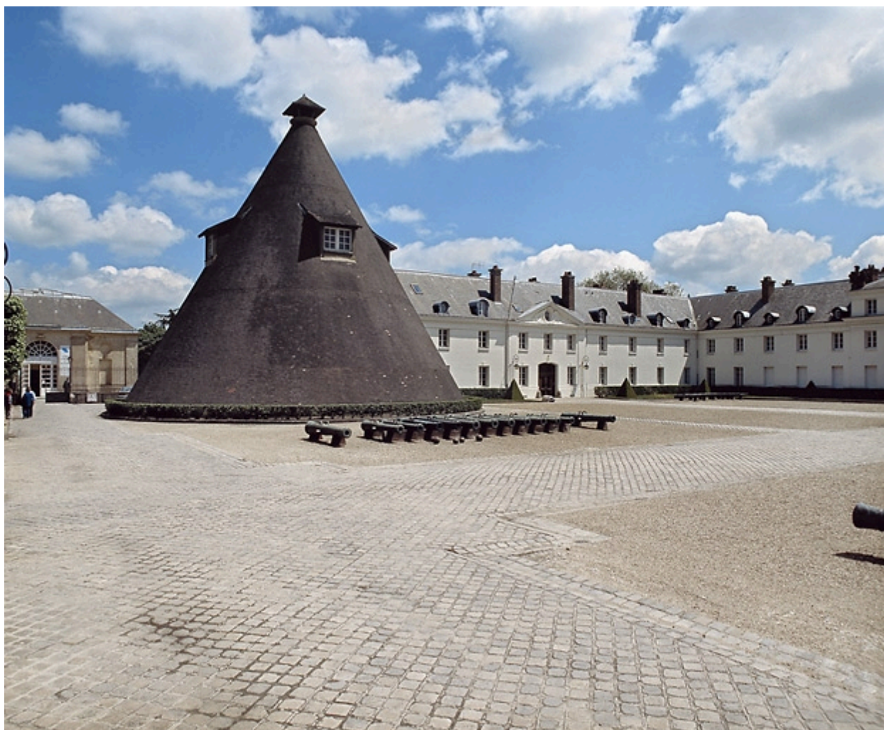
Vue d'ensemble, depuis l'ouest, en 1996.
