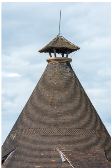
Toiture tronconique, avec oculus zénithal protégé par un petit toit en pavillon. Phot. Pierre-Marie Barbe-Richaud IVR26_20257100255NUC4A
