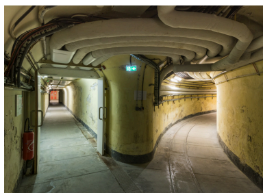
Sous-sol : couloir souterrain. A gauche desserte de la salle du jeu de paume (actuel Pavillon de l'Industrie), à droite de l'aile de la Marine. Phot. Pierre-Marie Barbe-Richaud IVR26_20257100334NUC4A
