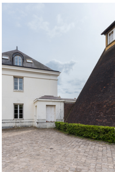
Corps de jonction avec l'aile de la Marine : élévation antérieure. Phot. Pierre-Marie Barbe-Richaud IVR26_20257100259NUC4A
