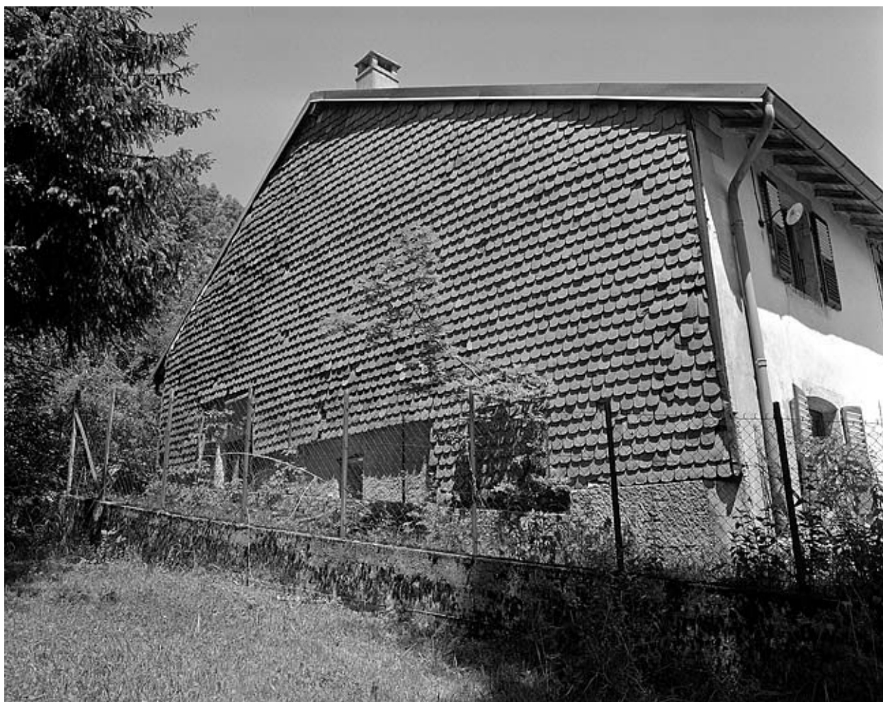
Essentage de tuiles sur un pignon sud-ouest.
