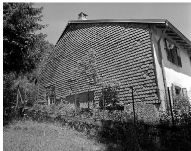
Essentage de tuiles sur un pignon sud-ouest. Phot. Jérôme Mongreville IVR43_19973900757X
