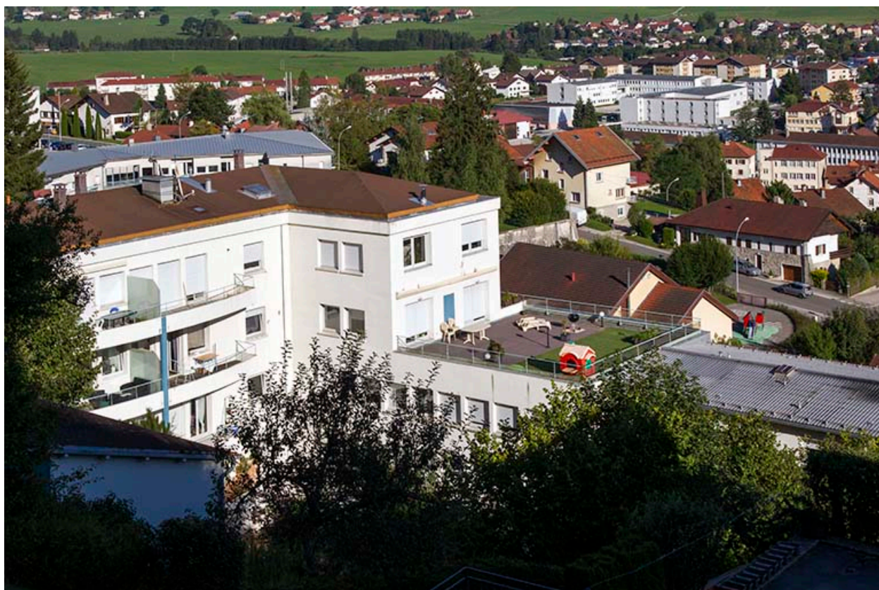
Façades postérieure et latérale gauche (vue plongeante).
