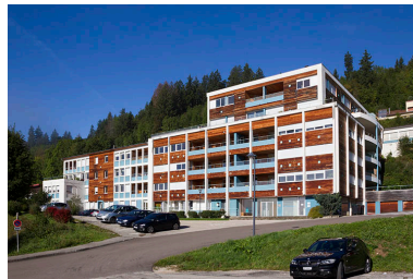
Vue d'ensemble rapprochée, depuis le sud-est. Phot. Yves Sancey IVR43_20132502014NUC2A
