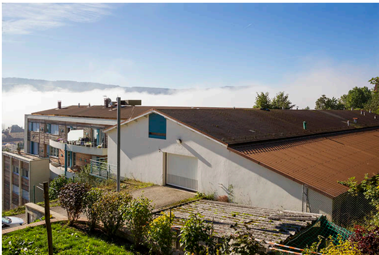
Façade latérale droite, de trois quarts droite.
