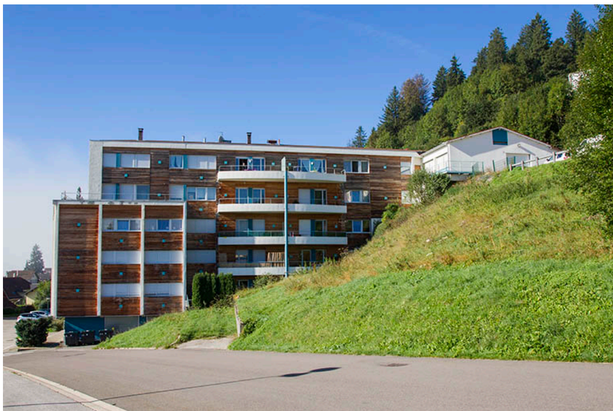
Façade latérale droite.
