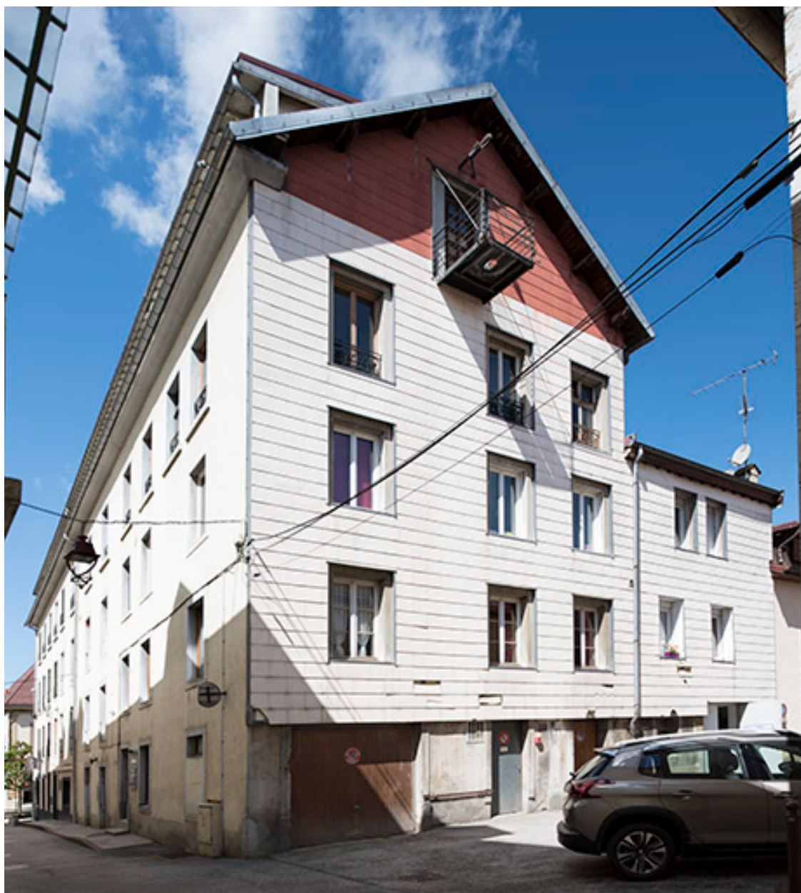
Façades postérieure et latérale droite.
