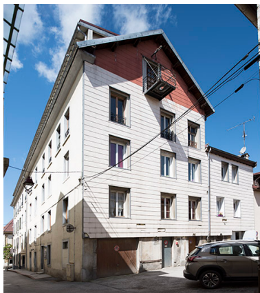
Façades postérieure et latérale droite.
