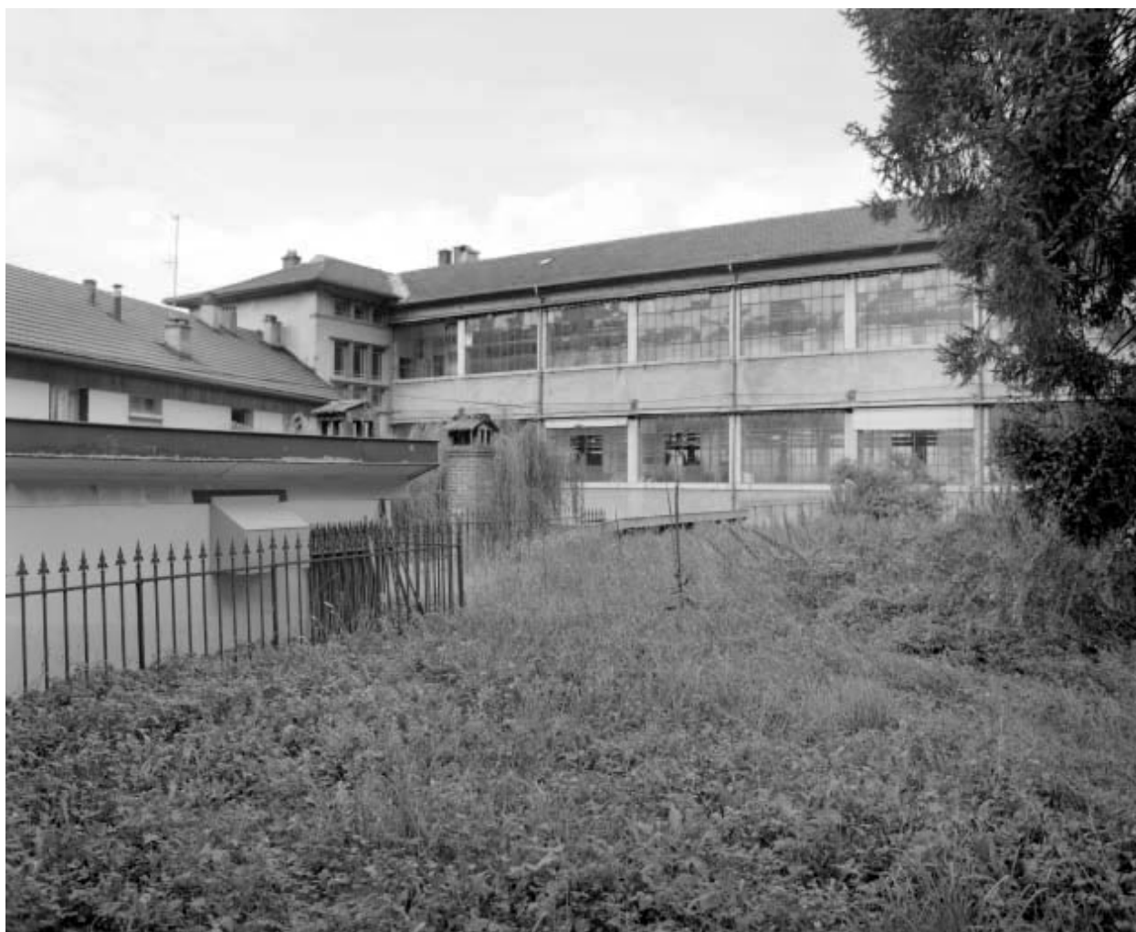
Façade latérale droite du 1er bâtiment.
