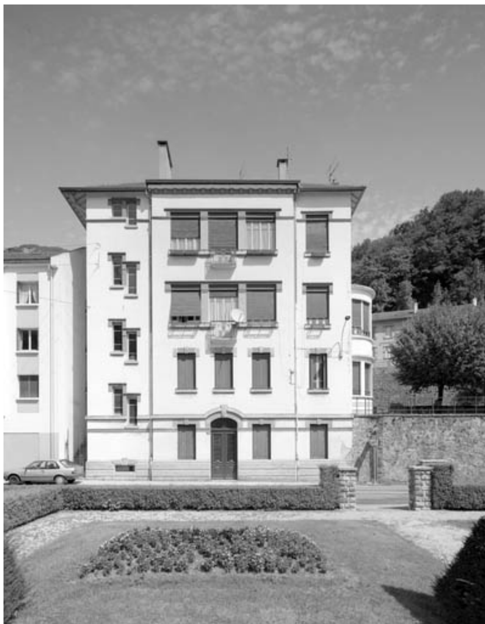
Façade du 2e bâtiment.
