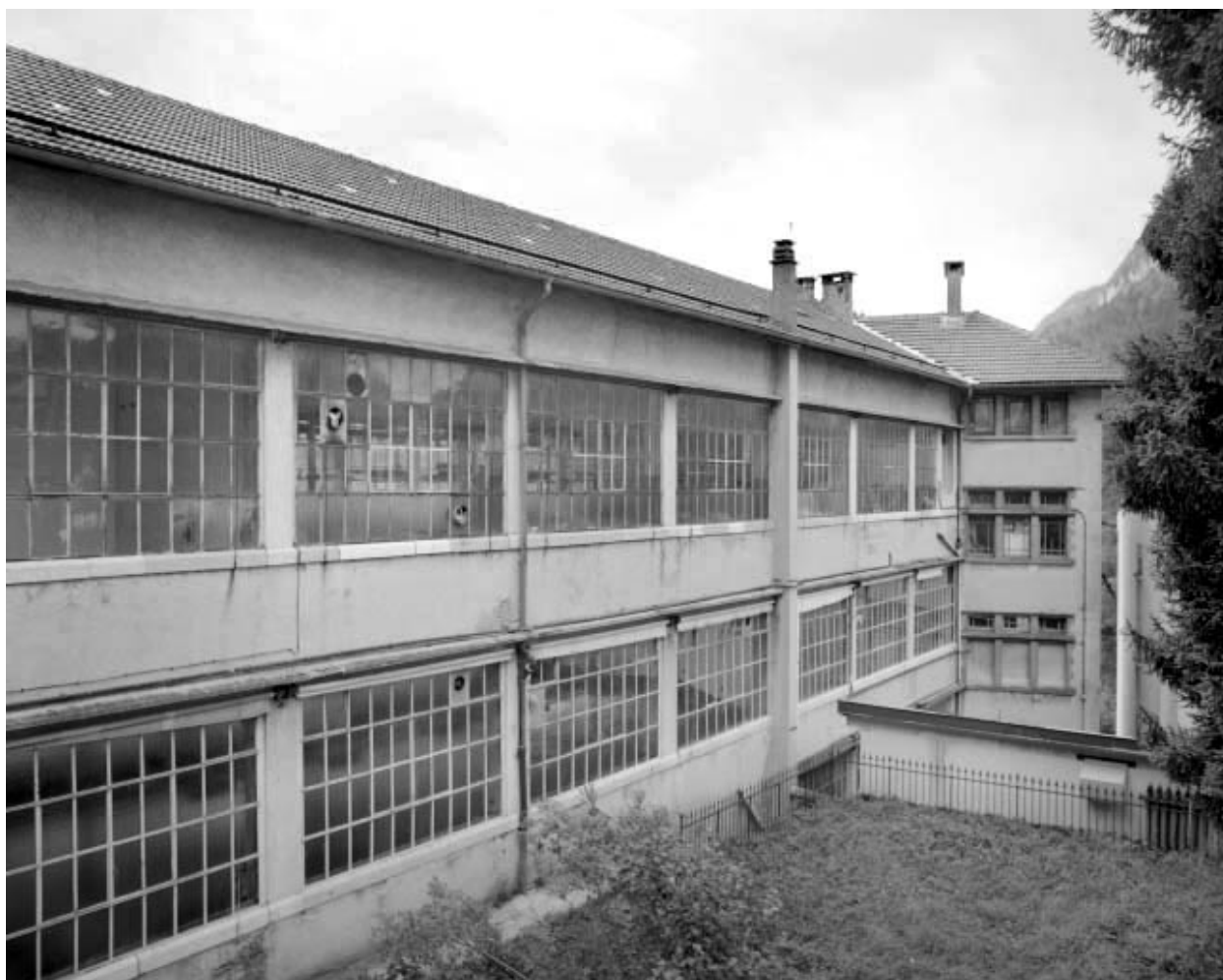
Façade latérale gauche du 2e bâtiment.
