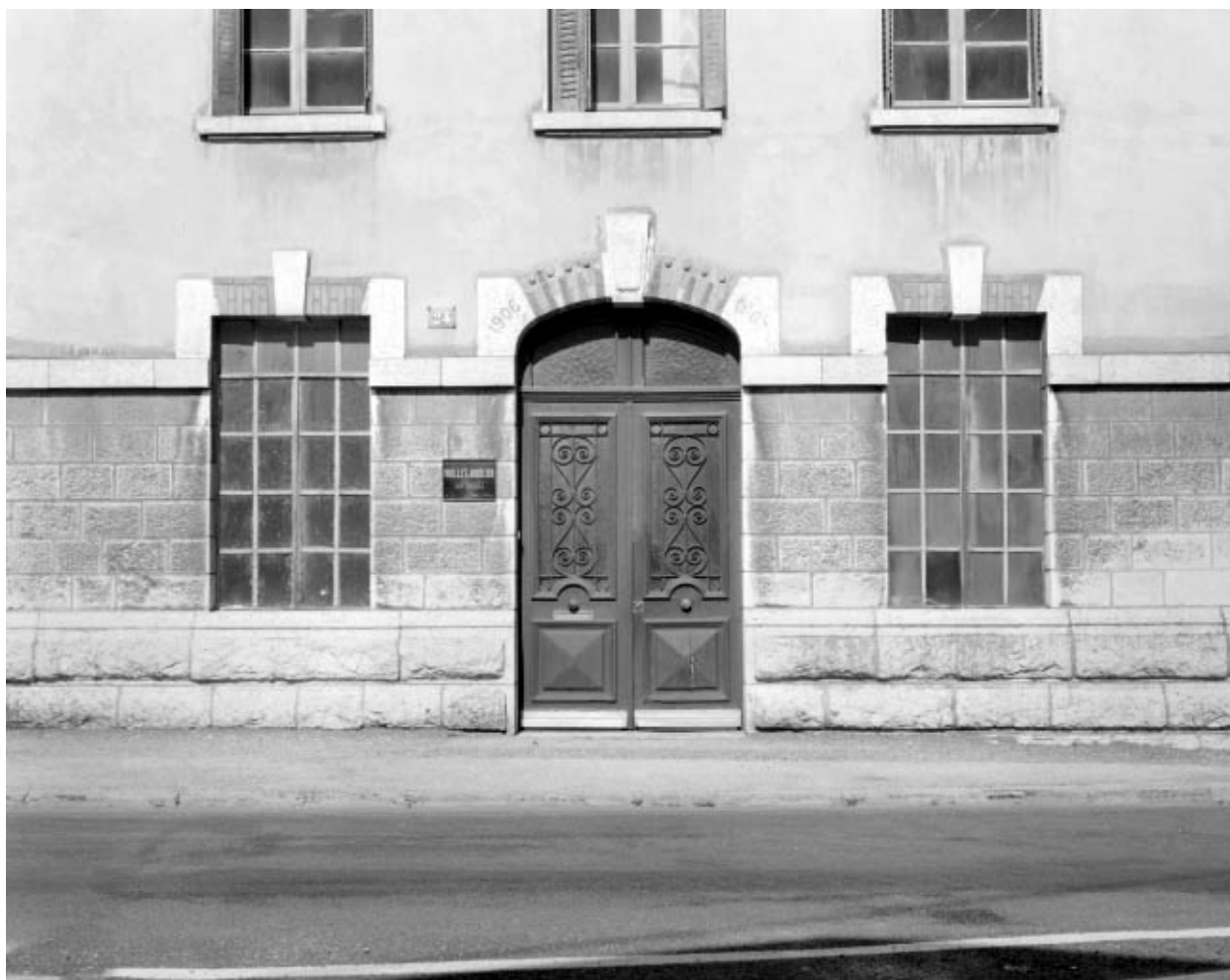
Entrée du 1er bâtiment.
