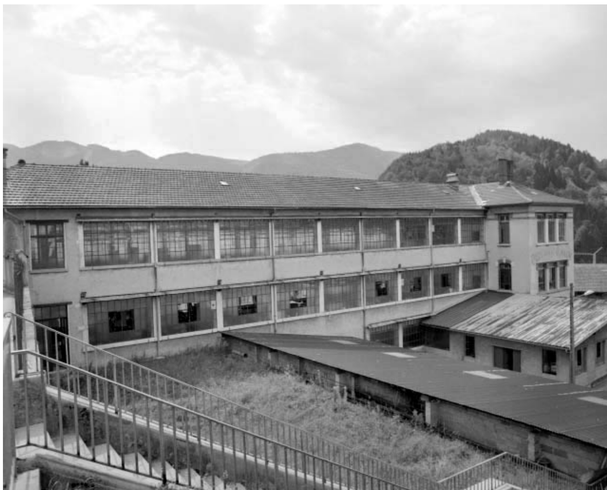
Façade latérale gauche du 1er bâtiment.
