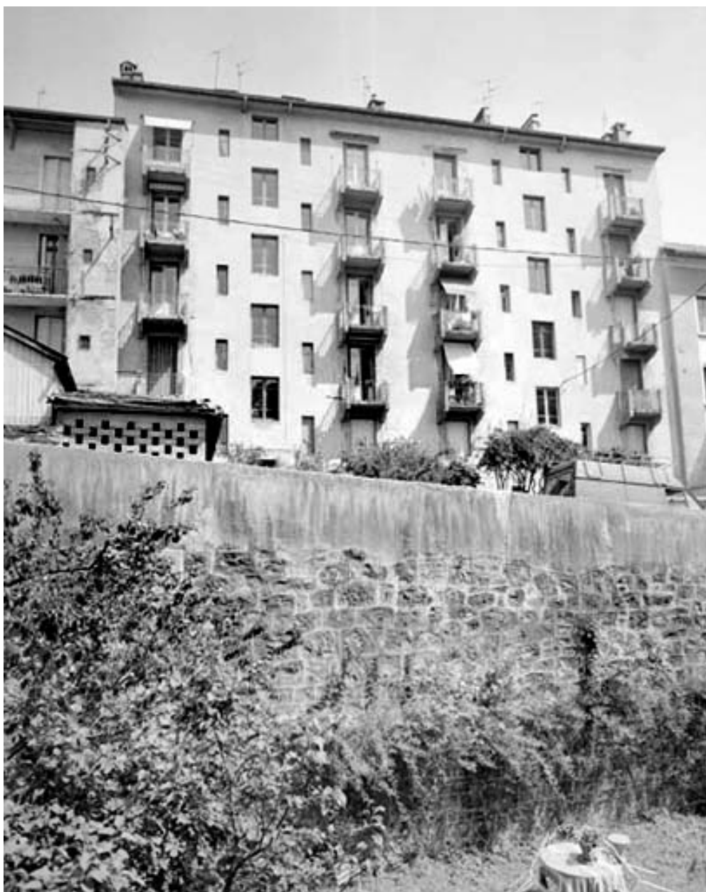
Façade postérieure de l'immeuble aux 15-17, rue Lançon.
