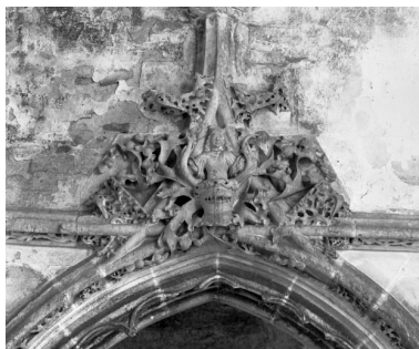
Couronnement de l'arcade côté chœur, détail. Phot. Jean-Luc Duthu IVR26_19872100353X
