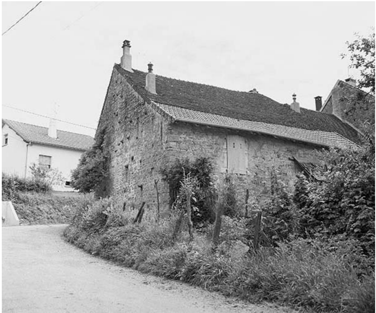
Façades postérieure et latérale droite.
