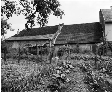
Façade postérieure. Phot. Yves Sancey IVR43_19823900091X
