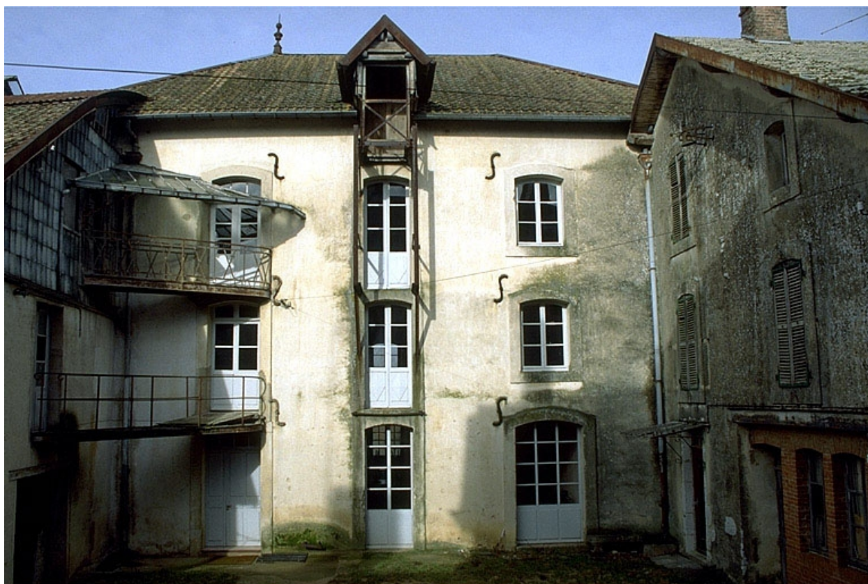
Façade antérieure de l'atelier de fabrication.
