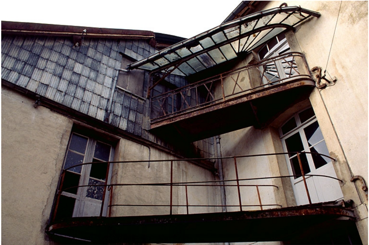
Ateliers de fabrication. Détail des passerelles.
