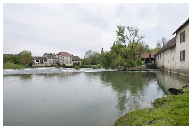
Vue d'ensemble depuis la rive droite. Phot. Jérôme Mongreville IVR43_20153900065NUC4A
