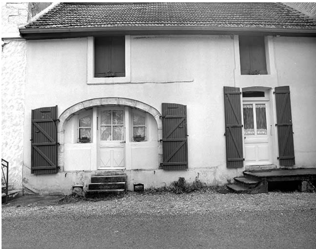
Façade antérieure du logement d'ouvriers.
