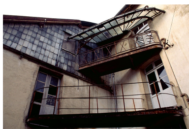
Ateliers de fabrication. Détail des passerelles.
