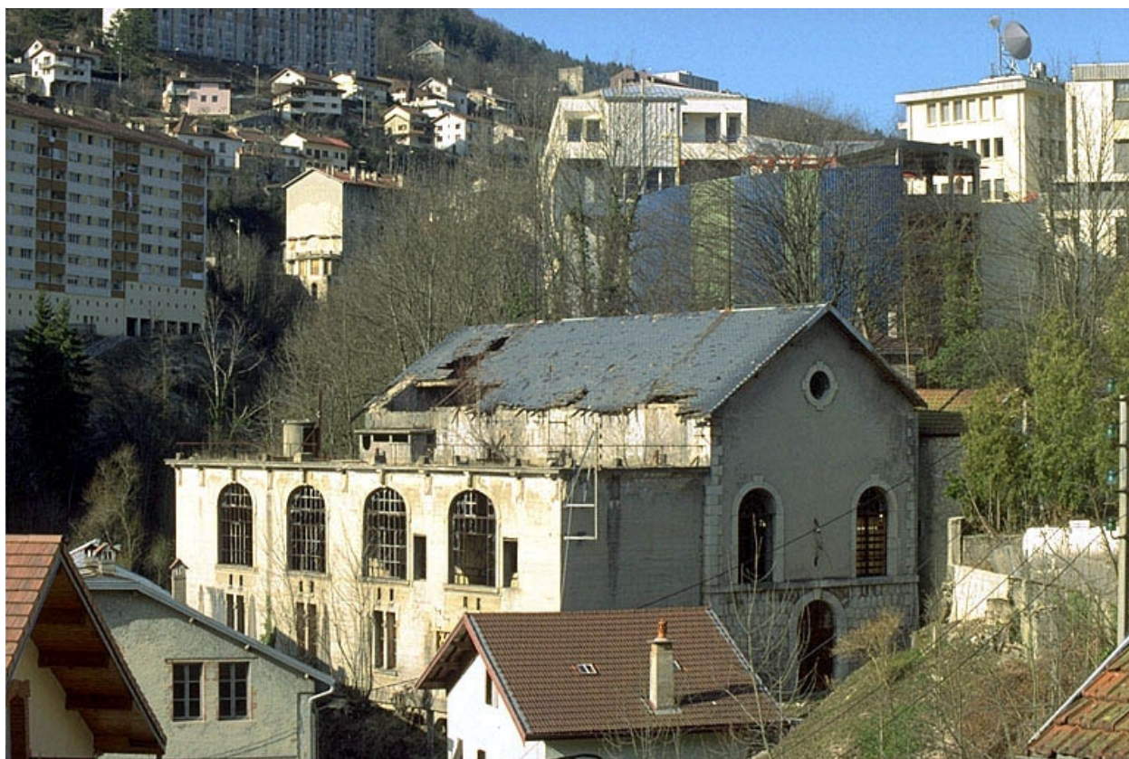
Vue d'ensemble rapprochée depuis le sud.
