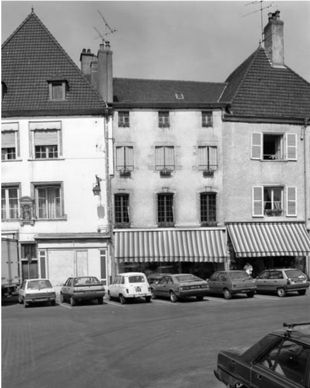
Façade antérieure, partie droite, de face.
