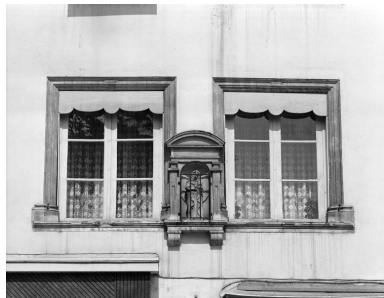
Façade antérieure : détail du premier étage. Phot. Yves Sancey IVR43_19897000293X
