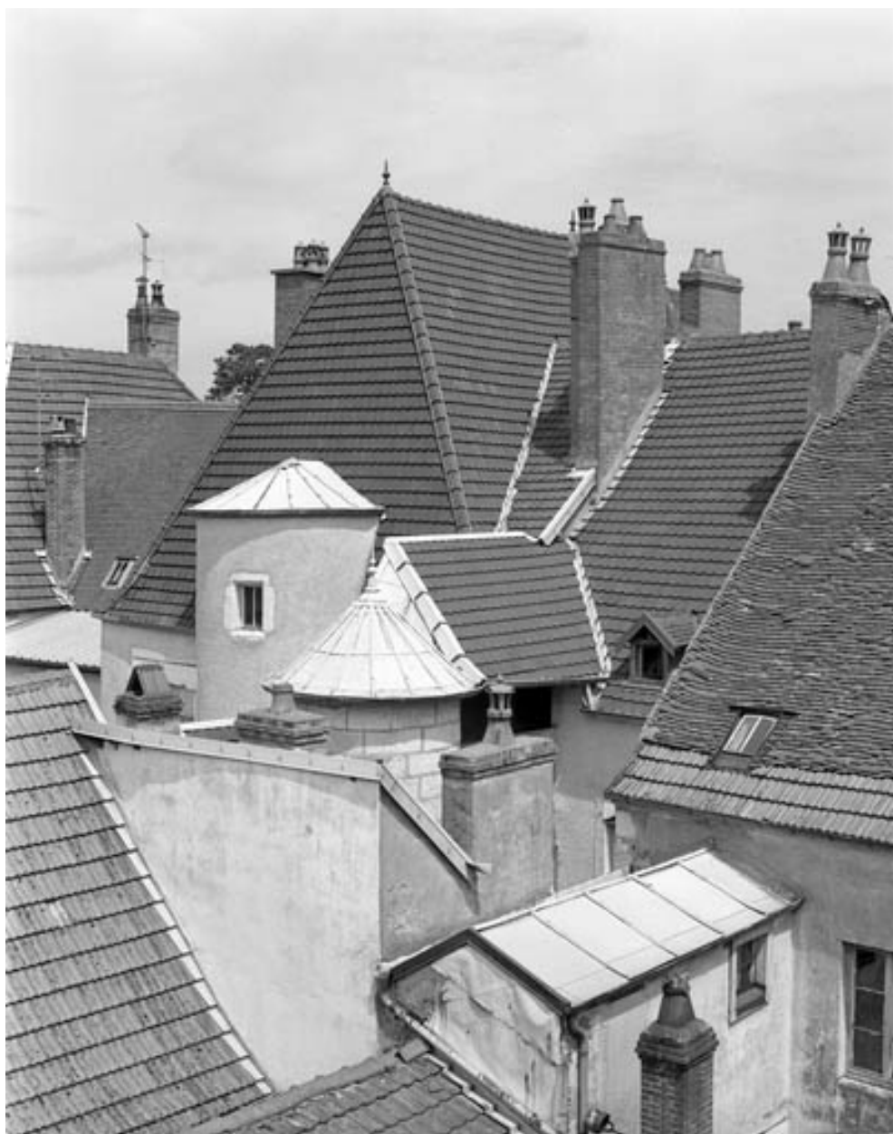
Façade postérieure : vue des toitures.
