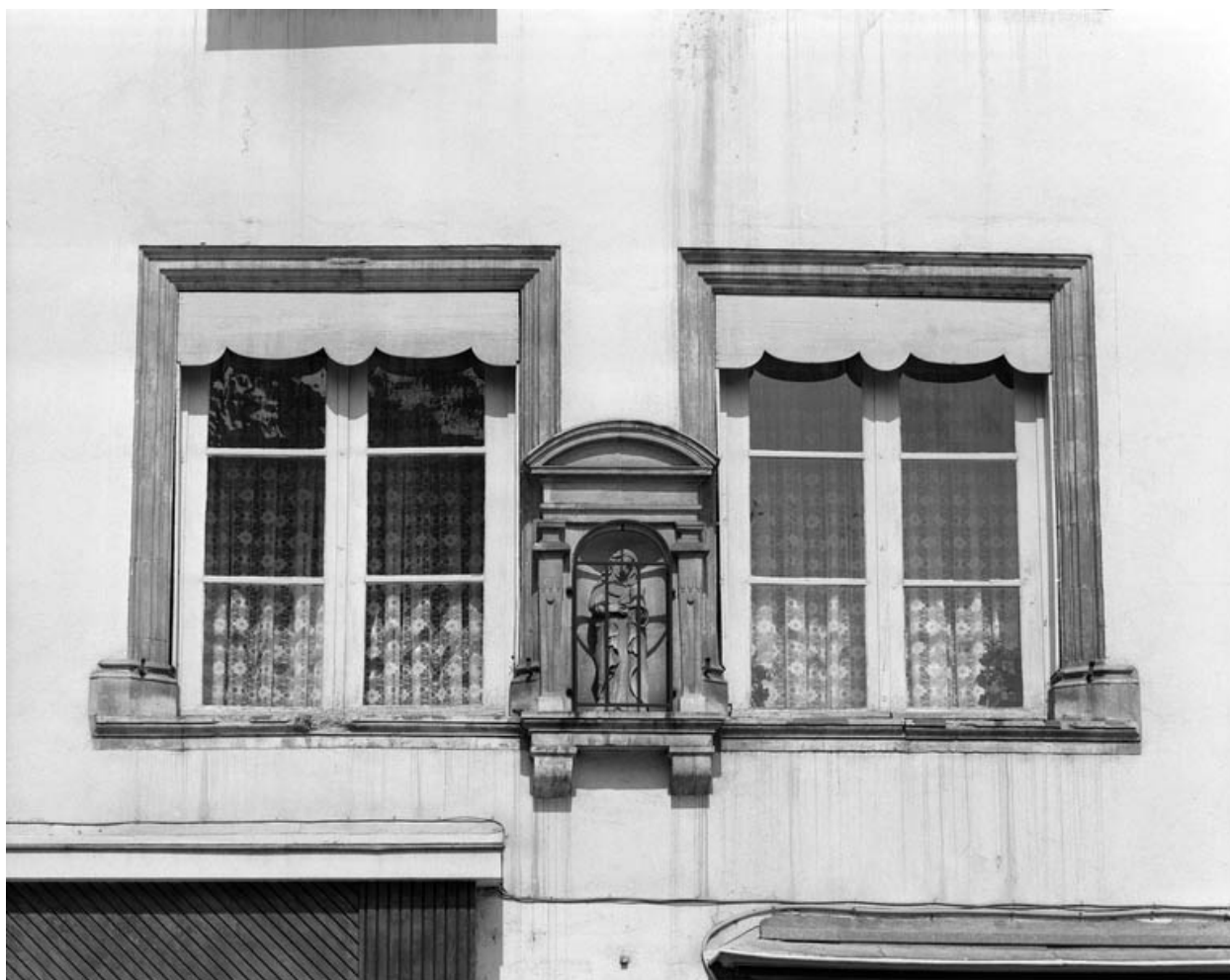
Façade antérieure : détail du premier étage.
