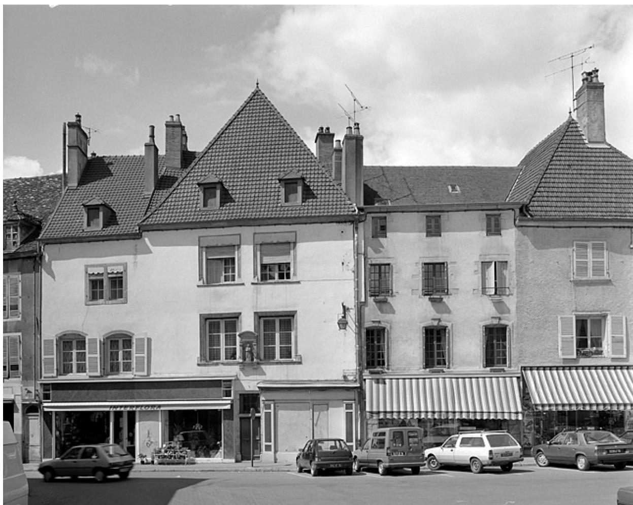
Vue d'ensemble façade antérieure, de face.
