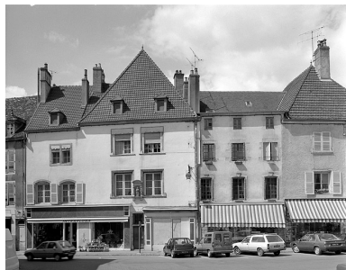
Vue d'ensemble façade antérieure, de face. Phot. Yves Sancey IVR43_19917000204X
