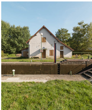
Vue de la maison éclusière. Phot. Pierre-Marie Barbe-Richaud IVR26_20177100397NUC2A
