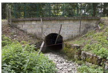
Pont sur la Servante (n ° 5), vu depuis l'amont. Phot. Jérôme Mongreville IVR43_20092501609NUC2A
