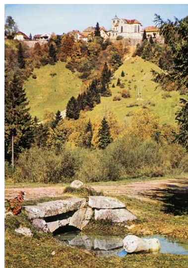
[Pont du ruisseau de la Goulette (n° 18), vu depuis l'amont], [3e quart 20e siècle]. Phot. IVR43_20112500015NUC4A
