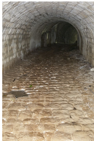
Intérieur du pont-aqueduc du Vaubillon (n° 6), détail du pavage. Phot. Jérôme Mongreville IVR43_20092501617NUC2A
