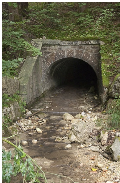
L'entrée du pont-aqueduc du Vaubillon (n° 6), aux Tavins. Phot. Jérôme Mongreville IVR43_20092501616NUC2A
