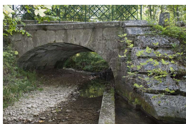
Pont sur la Jougne (n ° 3), vu depuis l'amont. Phot. Jérôme Mongreville IVR43_20092501605NUC2A
