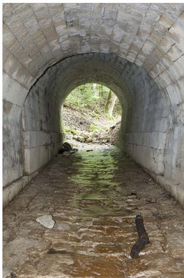
Intérieur du pont-aqueduc (n° 6) en direction des Tavins. Phot. Jérôme Mongreville IVR43_20092501614NUC2A
