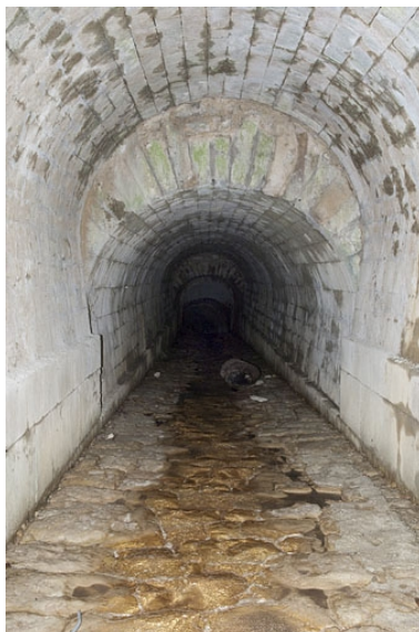
Détail de la voûte du pont-aqueduc du Vaubillon (n° 6). Phot. Jérôme Mongreville IVR43_20092501613NUC2A
