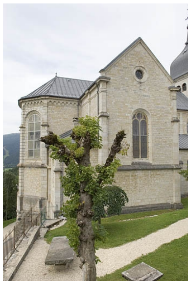
Chevet, depuis l'ouest. Phot. Jérôme Mongreville IVR43_20092501168NUC2A
