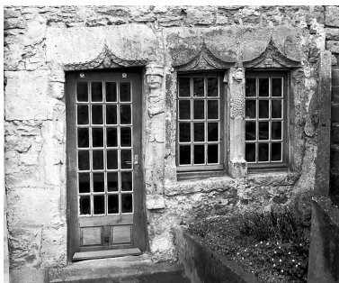
Vue d'ensemble des baies du côté cour. Phot. Yves Sancey IVR43_19772500182X
