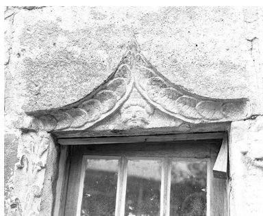
Détail du linteau de la baie gauche au rez-de-chaussée, côté cour. Phot. Yves Sancey IVR43_19772500186X
