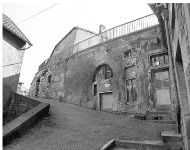
Vue rapprochée des élévations rue du Charri. Phot. Yves Sancey IVR43_19772500191X
