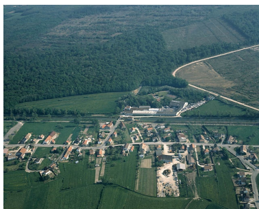
Vue aérienne, depuis le sud. Phot. Yves Sancey IVR43_19903900261XA
