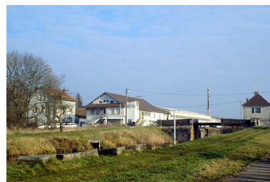
Vue d'ensemble depuis l'ouest. Phot. Laurent Poupard IVR43_19893901183ZA
