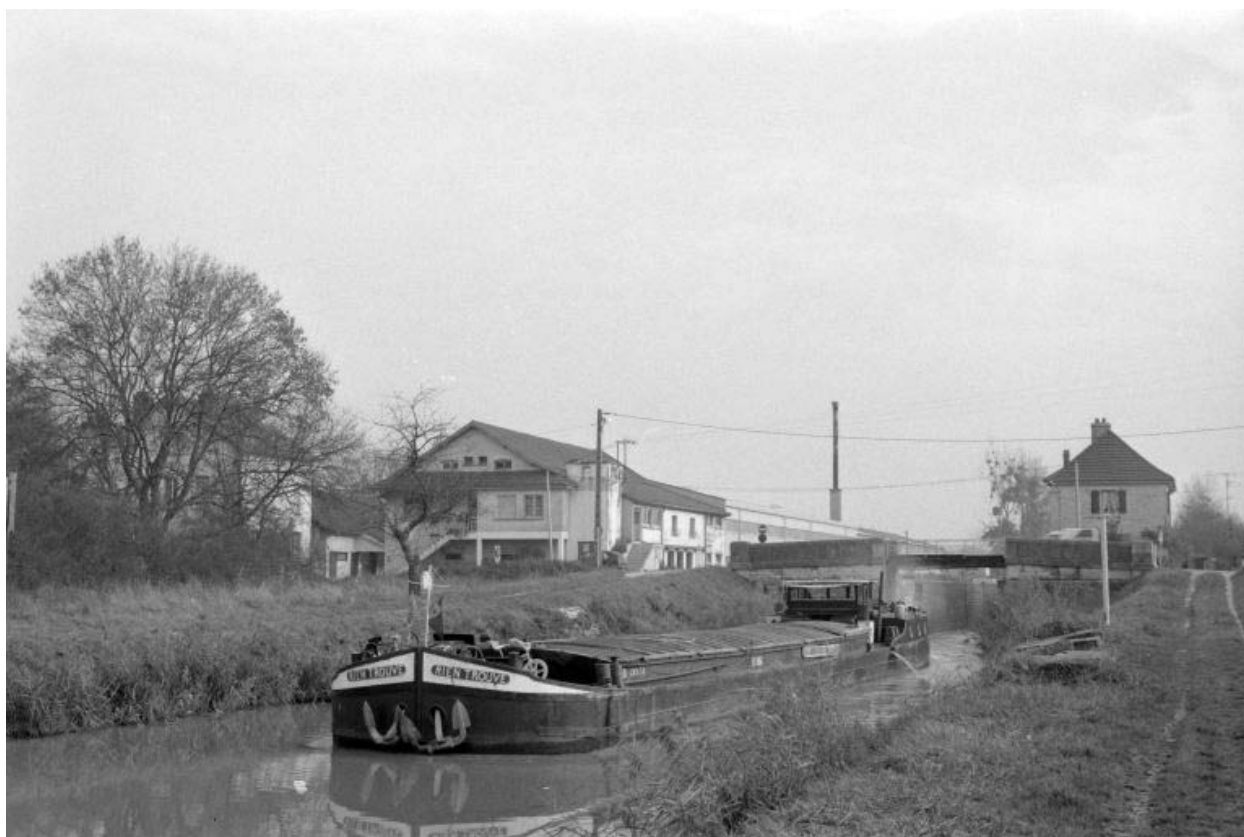
Vue d'ensemble depuis l'ouest, avec péniche.
