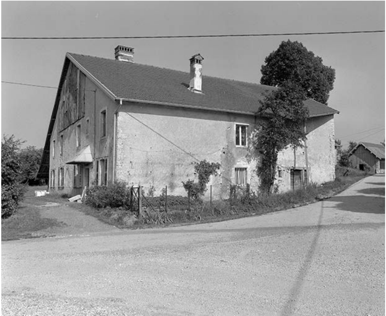
Façade antérieure et face latérale droite.
