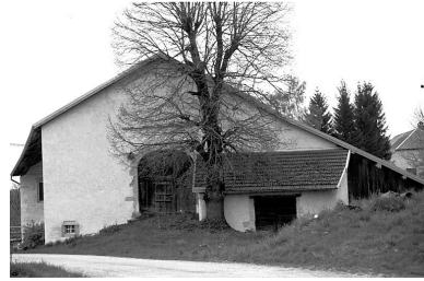
Façade postérieure. Phot. Liliane Hamelin IVR43_19992500149Z
