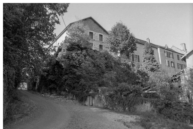
Façade est, partie gauche : vue depuis le chemin vicinal n°2 dit "des Grands Prés". Phot. Bernard Lardière IVR43_19797000371Z
