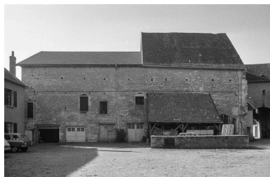
Cour : bâtiments agricoles. Phot. Bernard Lardière IVR43_19797000376Z
