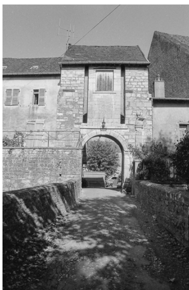
Ouvrage d'entrée : façade extérieure. Phot. Bernard Lardière IVR43_19797000373Z
