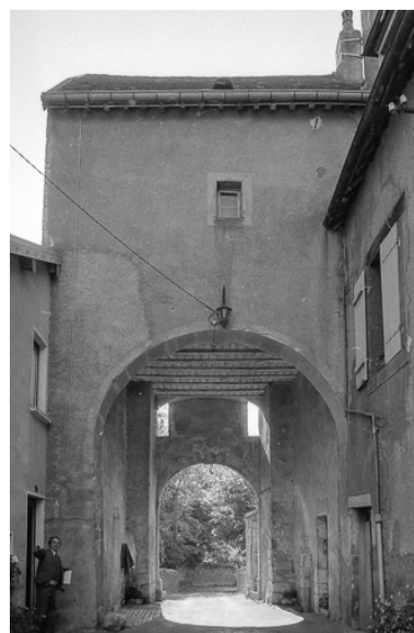
Ouvrage d'entrée : façade sur cour. Phot. Bernard Lardière IVR43_19797000374Z
