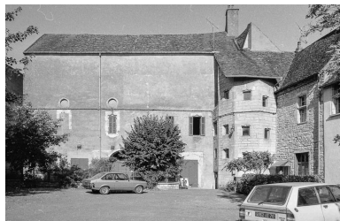
Façade sur cour. Phot. Bernard Lardière IVR43_19797000378Z
