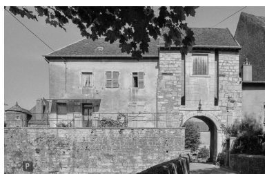
Ouvrage d'entrée et pont. Phot. Bernard Lardière IVR43_19797000372Z
