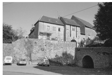
Ouvrage d'entrée et pont. Phot. Bernard Lardière IVR43_19797000370Z
