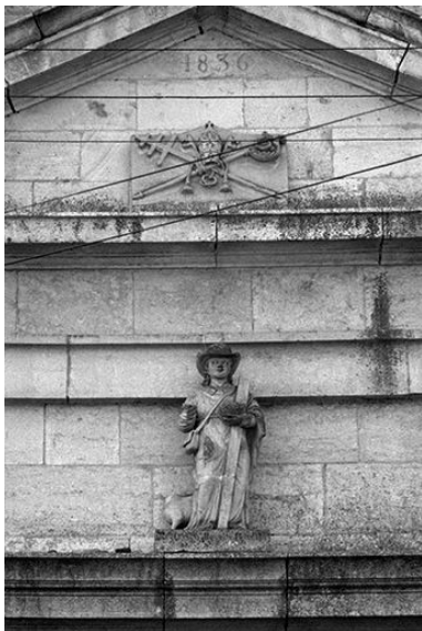
Vue d'ensemble avec cartouche. Phot. Yves Sancey IVR43_19757000020Z
