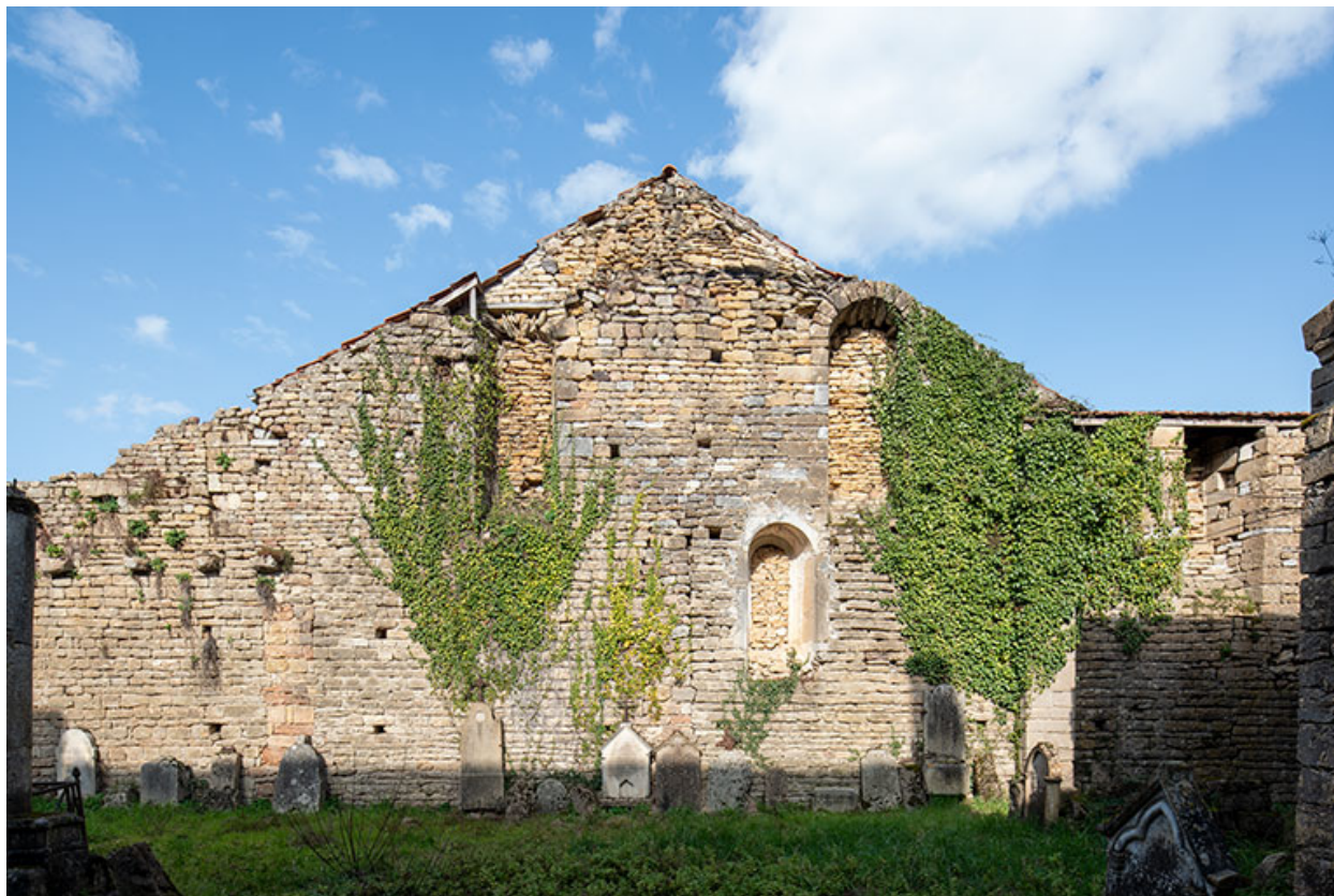
Mur nord de l'église, côté intérieur.
