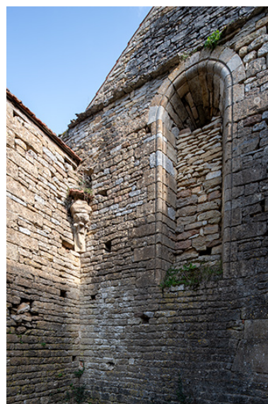
La chapelle nord attenante au chevet : détail de l'angle nord-est. Phot. Nicolas Waltefaugle IVR26_20268900022NUC4A
