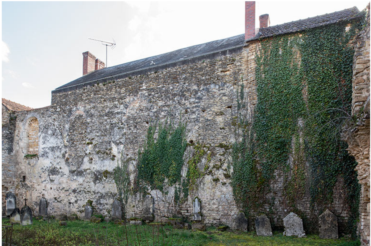
Le mur sud de l'église, côté intérieur.
