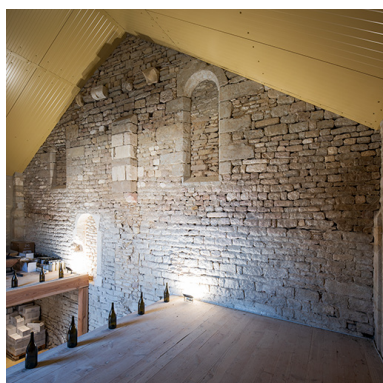
Mur nord de l'église, côté extérieur, dans une ferme. Phot. Nicolas Waltefaugle IVR26_20268900015NUC4A
