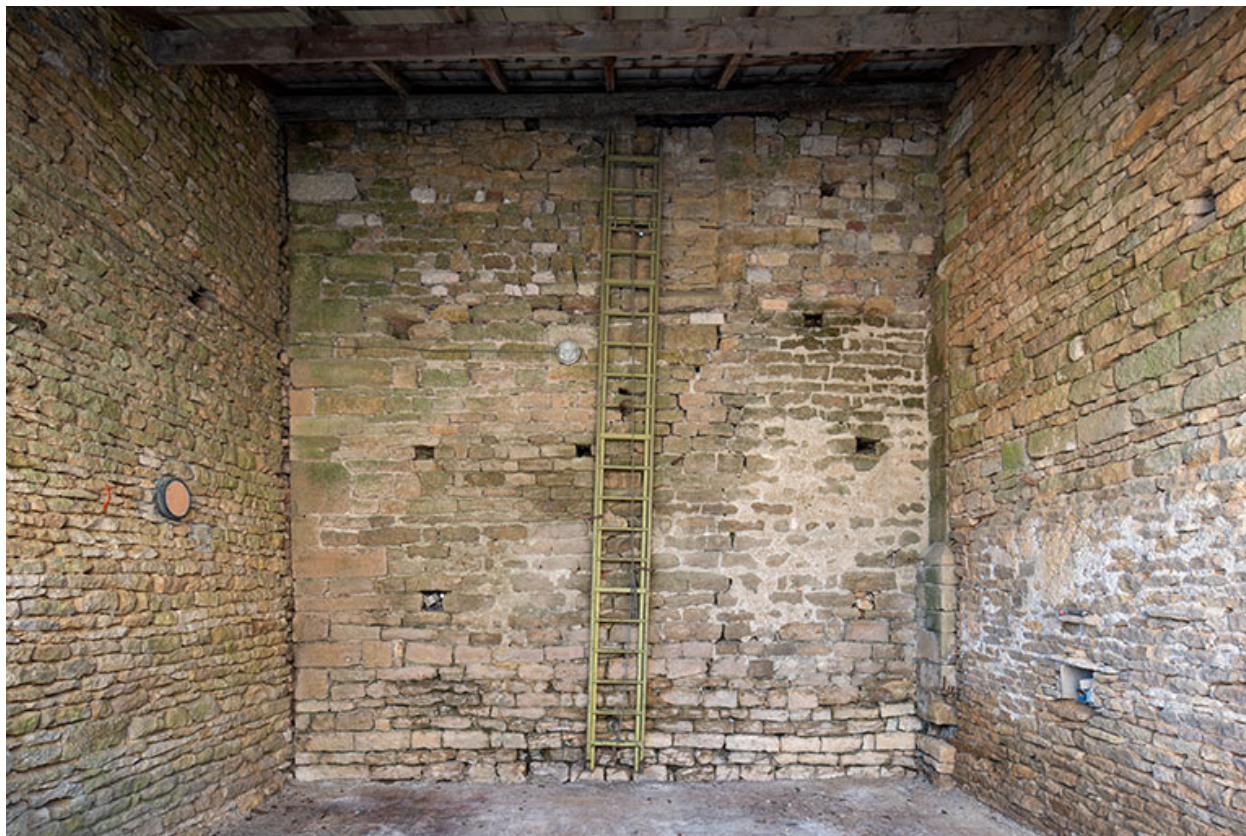
Mur nord de l'église, côté extérieur, dans une remise.
