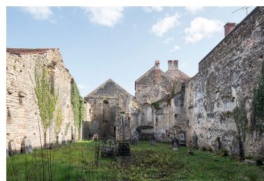
L'ancienne église, en direction de l'est. Phot. Nicolas Waltefaugle IVR26_20268900017NUC4A
