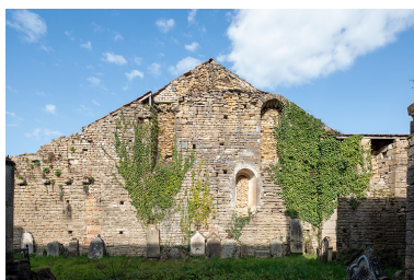
Mur nord de l'église, côté intérieur. Phot. Nicolas Waltefaugle IVR26_20268900019NUC4A
