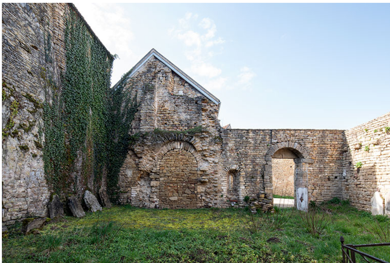
L'ancienne église, en direction de l'ouest.
