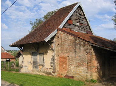
Vue d'ensemble de la façade.
