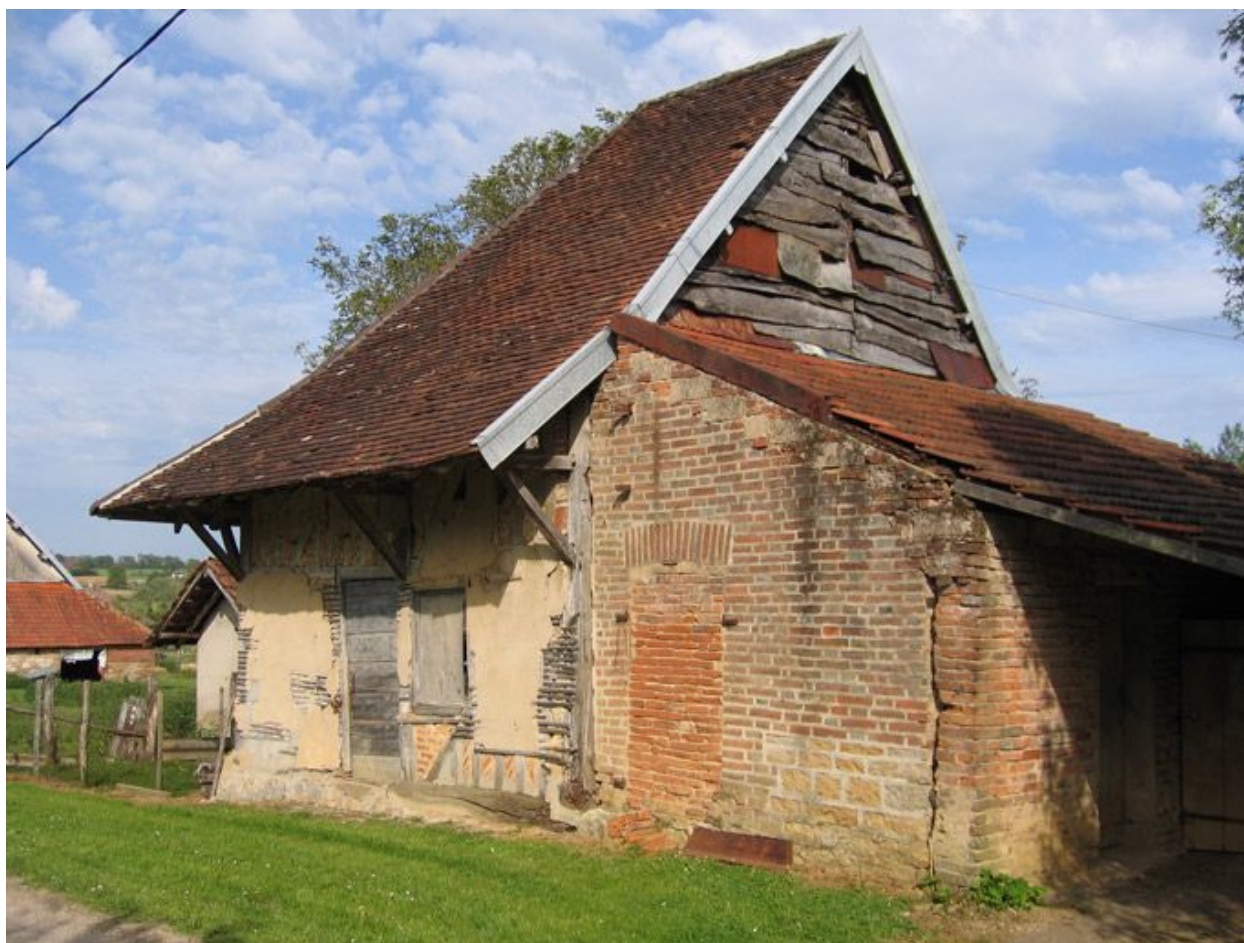
Vue d'ensemble de la façade.
