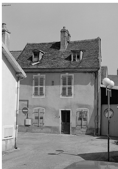
Maison située 8 rue des Champs. Phot. Yves Sancey IVR43_19917000022X
