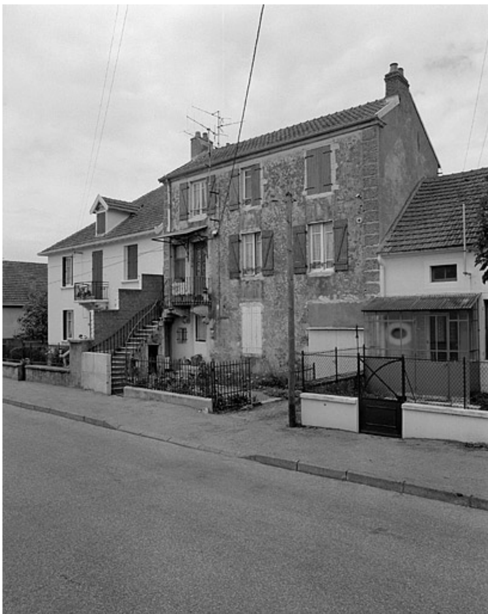
Maisons situées avenue Jean Jaurès.
