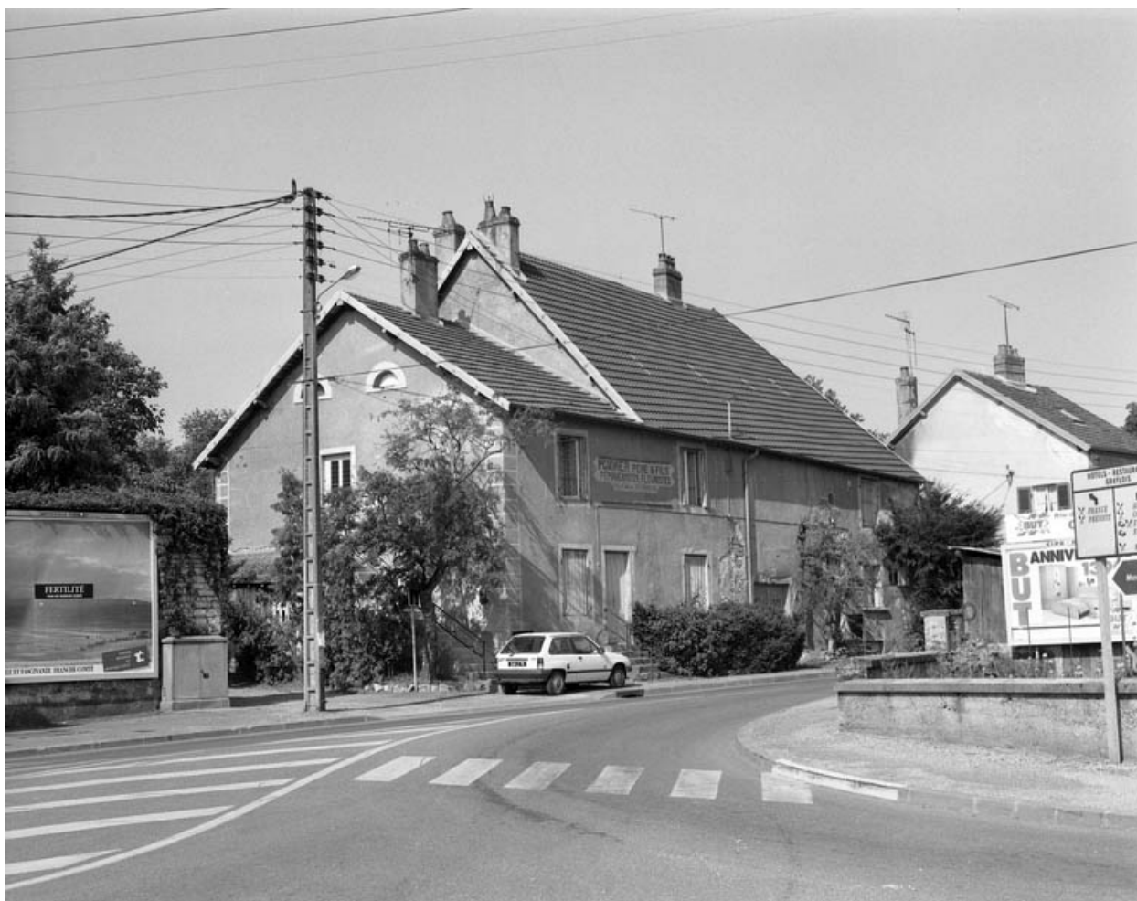
Maison située 50 rue Levy.
