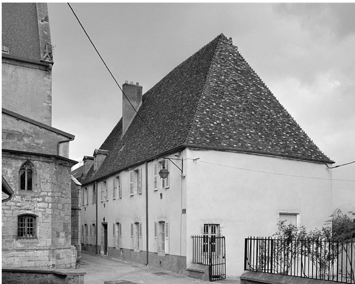
Maison située 7 rue Pigalle.
