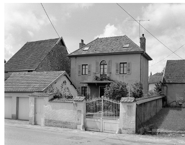
Maison située 18 rue de la Vieille Tuilerie. Phot. Yves Sancey IVR43_19917000396X
