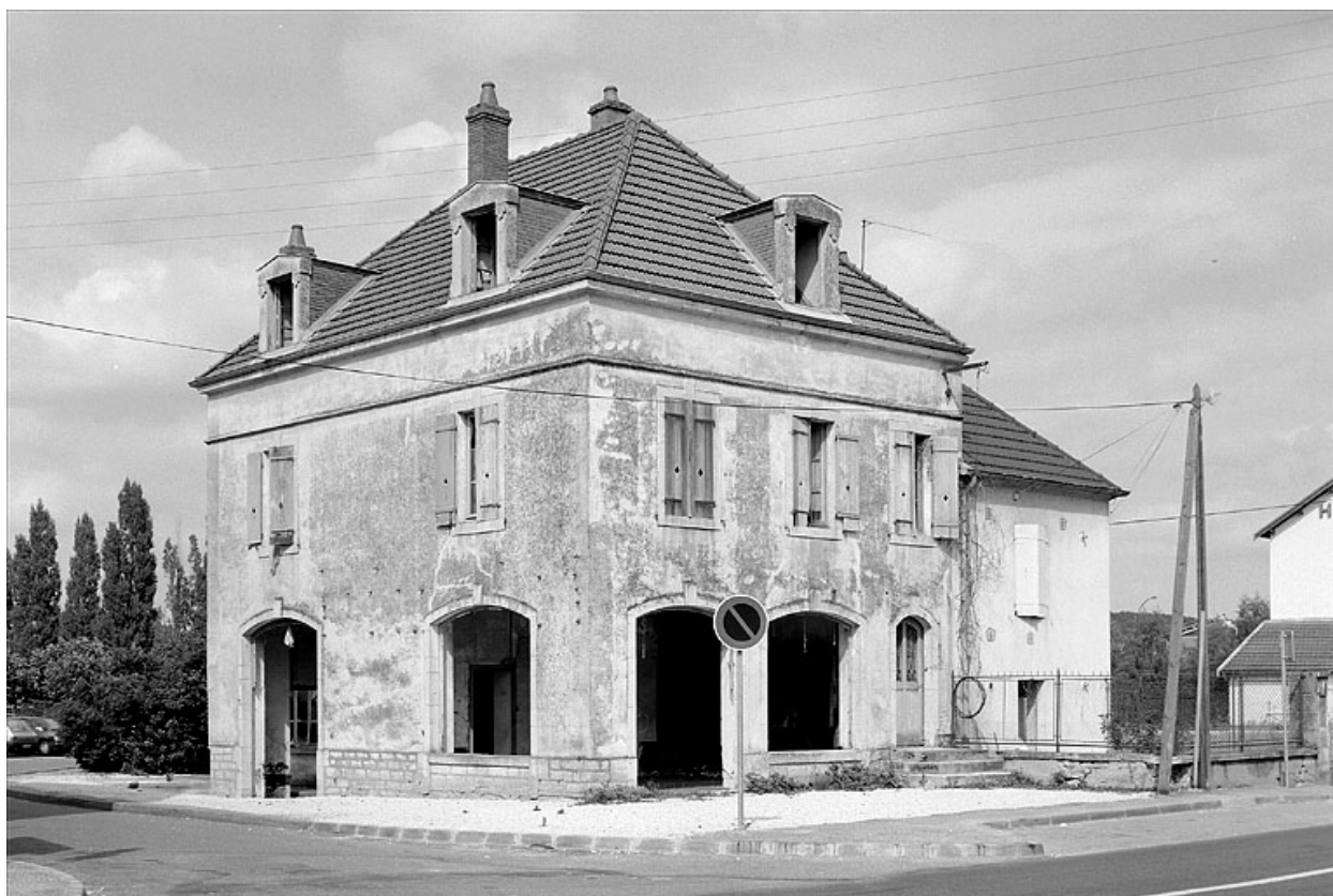
Maison de commerçant située 3 avenue Carnot.
