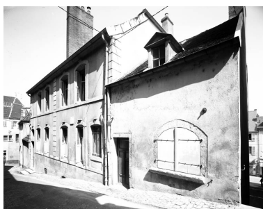
Maison située 8 et 8bis rue de la Malcouverte. Phot. Yves Sancey IVR43_19897000392V
