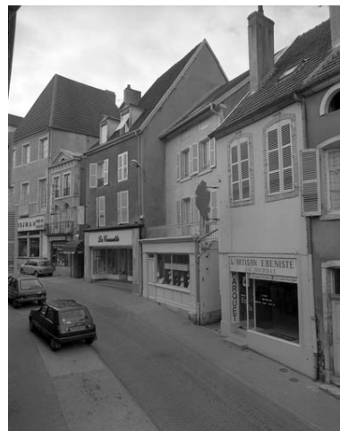
Maisons situées Grande Rue. Phot. Yves Sancey IVR43_19897000090X
