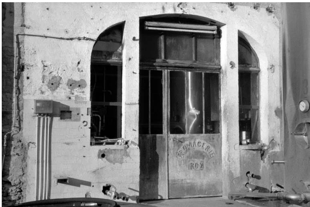
Porte d'entrée de l'atelier de fabrication.
