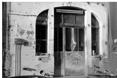
Porte d'entrée de l'atelier de fabrication. Phot. Laurent Poupard IVR43_19893900344Z
