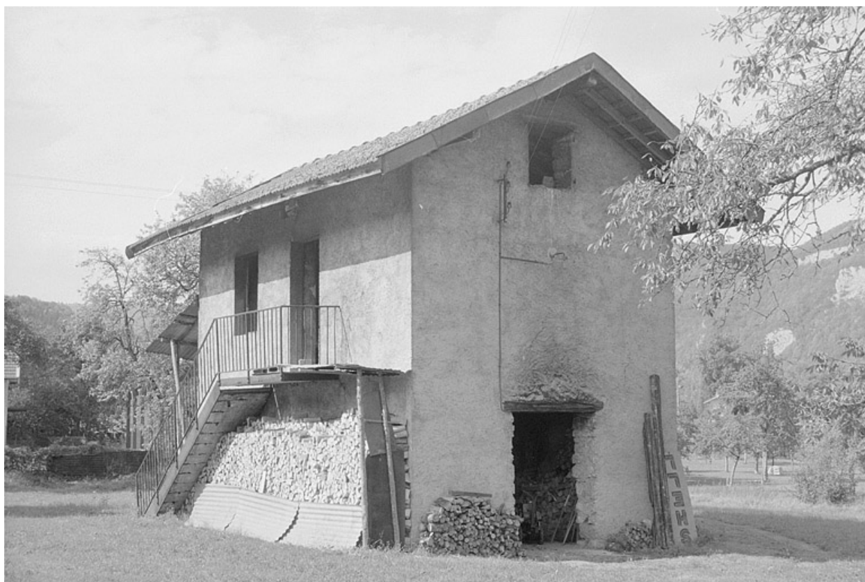
Bâtiment du four et du logement d'ouvriers.
