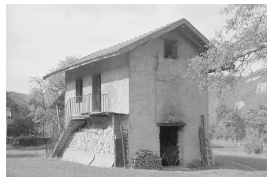
Bâtiment du four et du logement d'ouvriers. Phot. Laurent Poupard IVR43_19903900509Z
